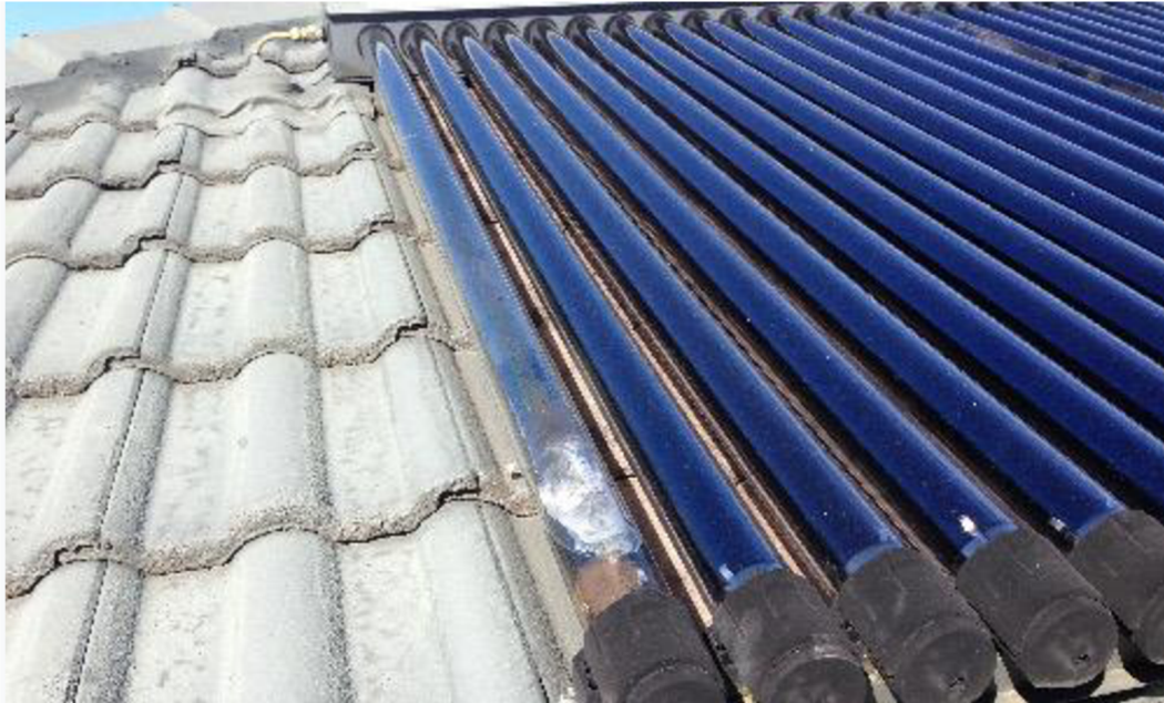
Obrázok 1. 10 – Poškodená trubica vplyvom krupobitia [13]
