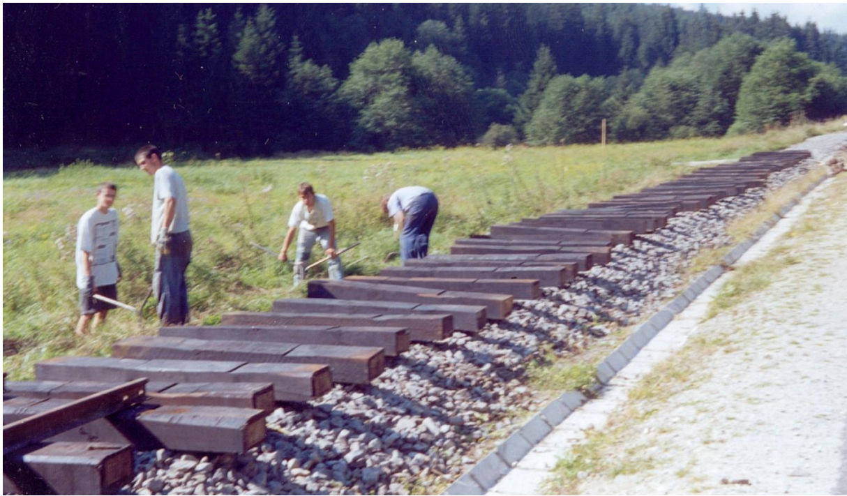
Obr. 3.2.2 Dřevěné pražce, připravené k upevnění kolejnic [25]
