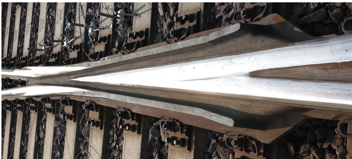
Obr. 3.1.4 Srdcovková část výhybky č. 3
