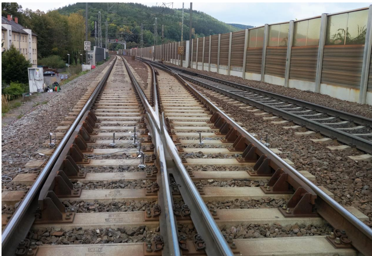
Obr. 5.1.2 Pohled na výchybku č. 3 v žst. Ústí nad Orlicí
