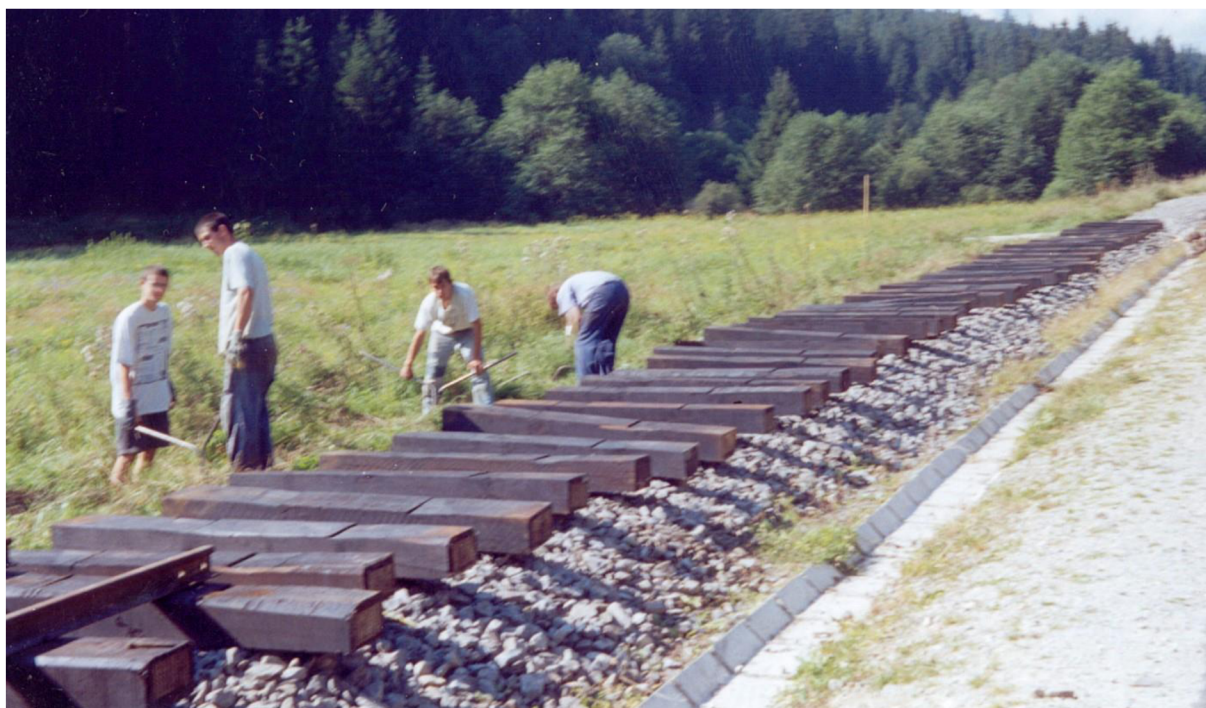
Obr. 3.2.2 Dřevěné pražce, připravené k upevnění kolejnic [25]
