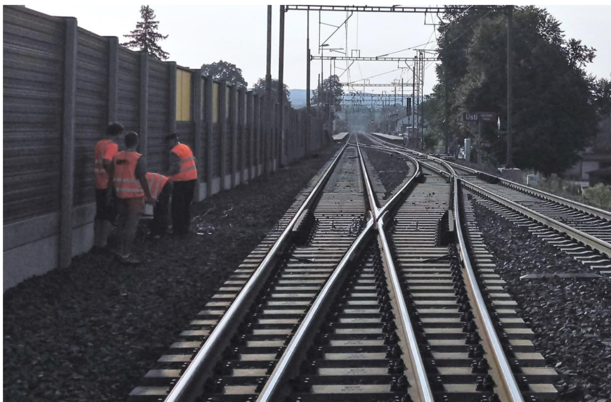
Obr. 5.1.3 Pohled na výhybku č. 4 v žst. Ústí nad Orlicí
