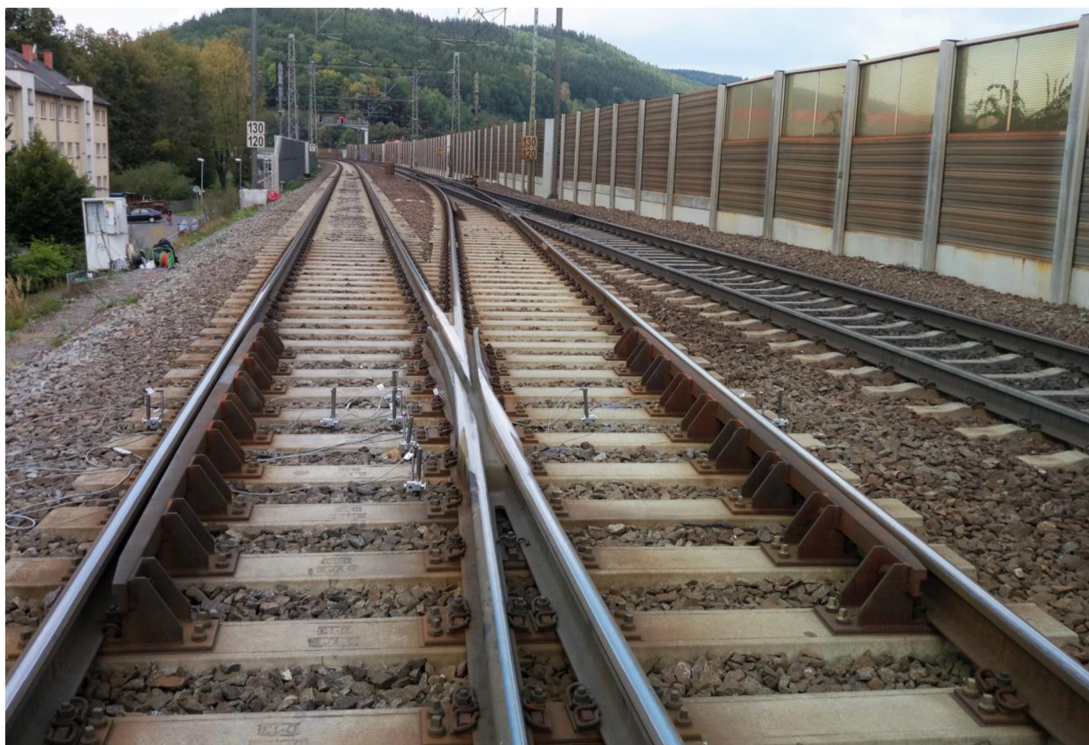
Obr. 5.1.2 Pohled na výhybku č. 3 v žst. Ústí nad Orlicí
