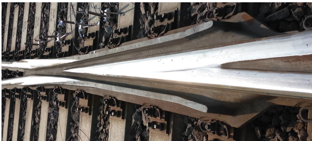
Obr. 3.1.4 Srdcovková část výhybky č. 3
