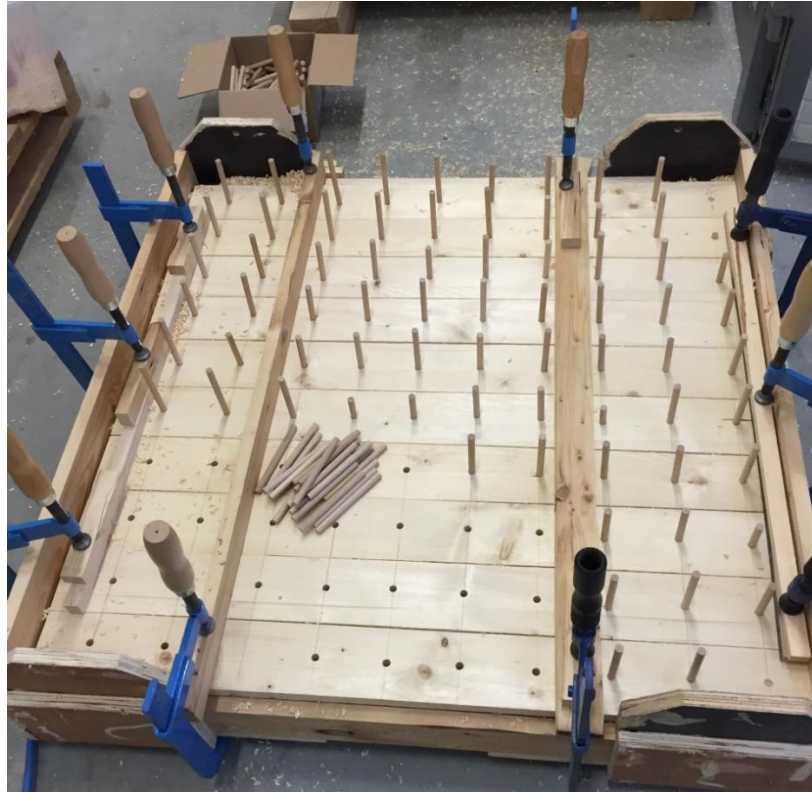
Obr. 12 Vtloukání kolíků do panelu
