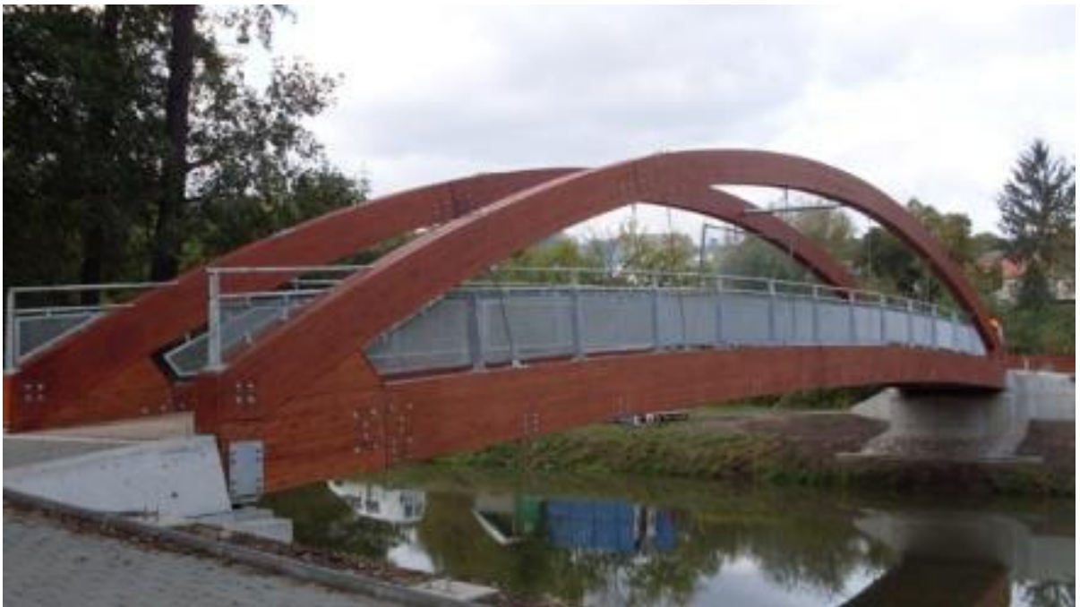
Obr.5 Dřevěná mostní konstrukce
