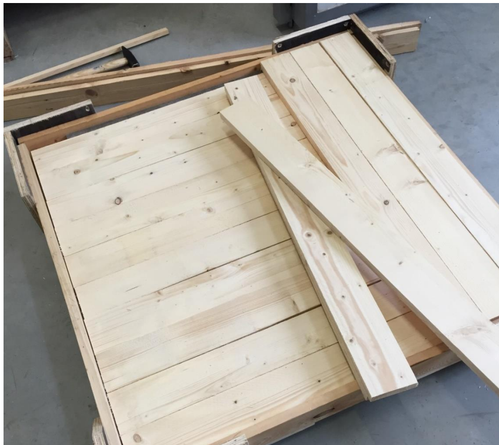
Obr. 9 Kladení lamel do připraveného rámu
