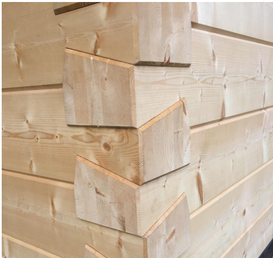
Obr. 4 Detail roubení z lepeného dřeva
