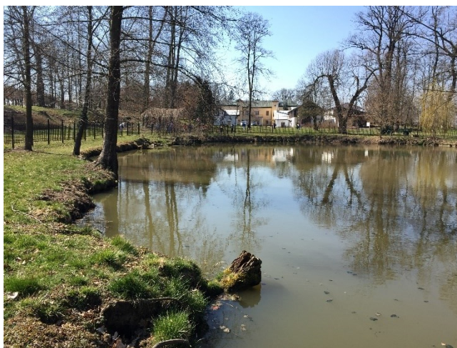
Obr. 41 Narušené břehy (Trtílková, IV/2020) [22]
