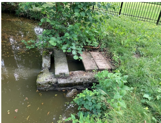
Obr. 34 Stávající betonový vtokový objekt (Majkus, IX/2021)
