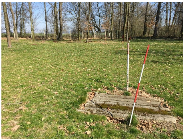
Obr. 32 Betonové šachty stávajícího trubního přivaděče (Trtílková, IV/2020) [22]
