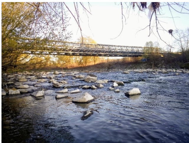
Obr. 10 Balvanitý skluz na řece Bečvě (Majkus, IV/2020)
