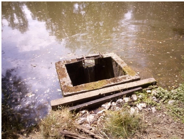
Obr. 42 Betonový otevřený požerák (Majkus, VII/2020)
