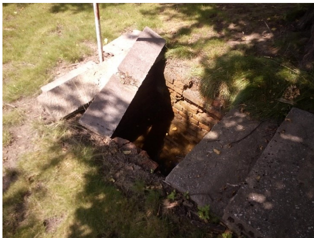
Obr. 33 Odkrytá kontrolní šachta (Majkus, VII/2020)
