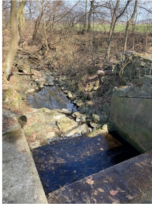
Obr. 25 Koryto Hlubockého potoka pod spádovým stupněm (Majkus, III/2021)
