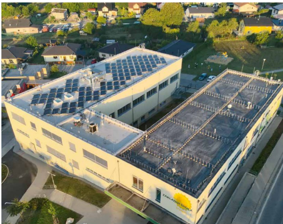
Obrázek 15 Přístavba Základní školy Srubec
