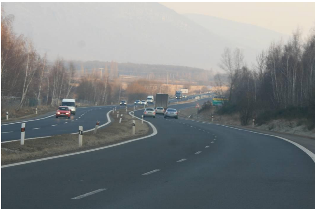
Obr. č. 8: Úsek hodnoceného silnice výjezd u obce Jirkov směr Most: ( foto autor)
