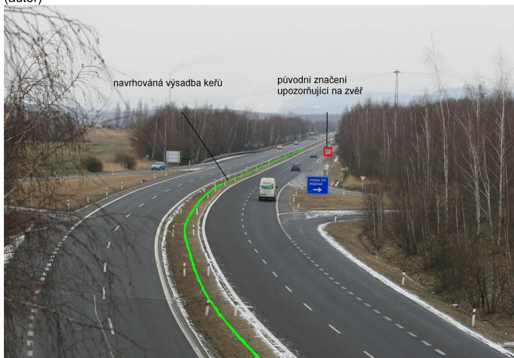
Obr. č. 33: Rizikový úsek č. 2, u Vysoké Pece, pohled směr na Most. S vyznačením navrhovaného opatření a současným umístěním dopravní značky upozorňující na zvěř. (autor)
