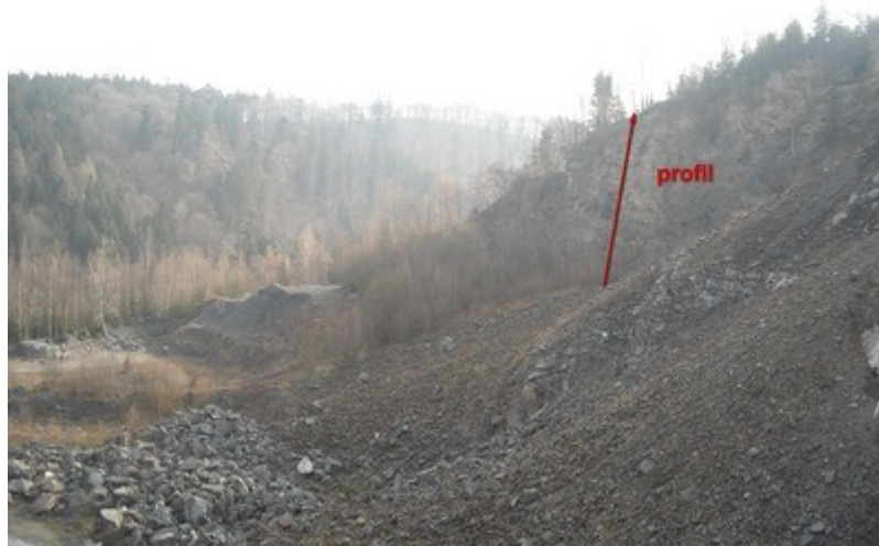
Obr.11 : Bývalý železniční lom u Domašova nad Bystřicí.
