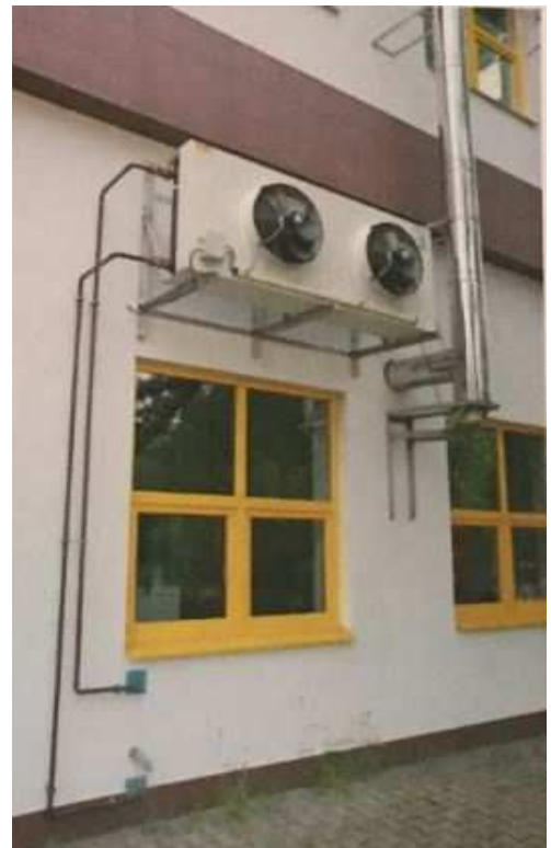
Obrázek č. 21: Chladicí systém (vnitřní část vlevo) a venkovní výměník (vpravo) (Fajman, vlastní fotografie)
