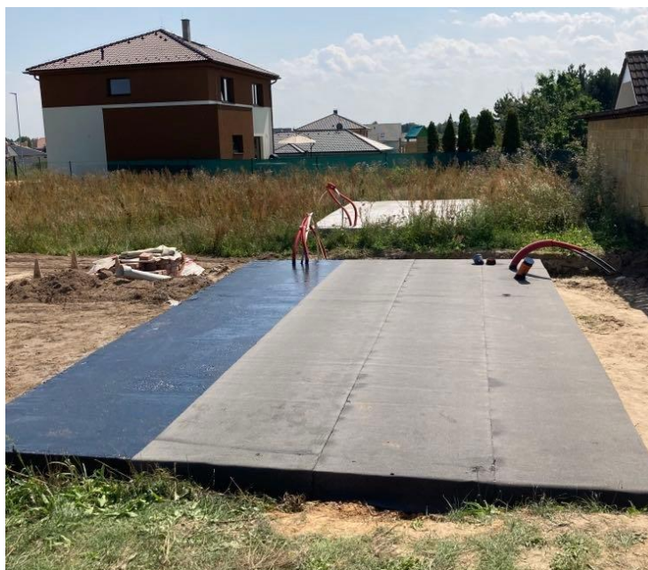
Obrázek 9 – Pokládka asfaltových hydroizolačních pásů
