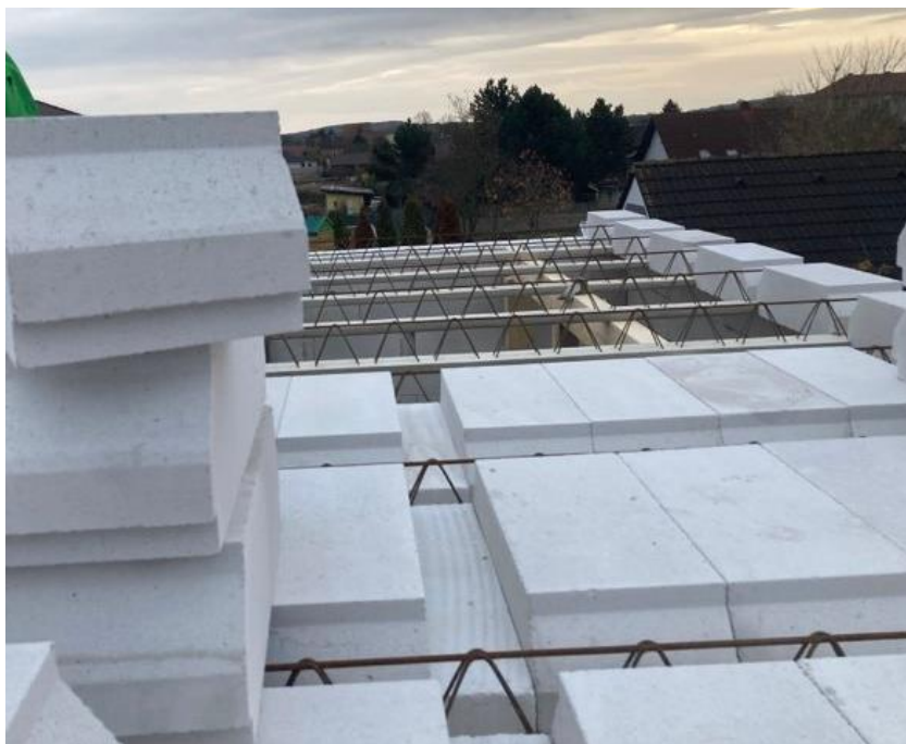
Obrázek 10 – Pokládka stropních dílců
