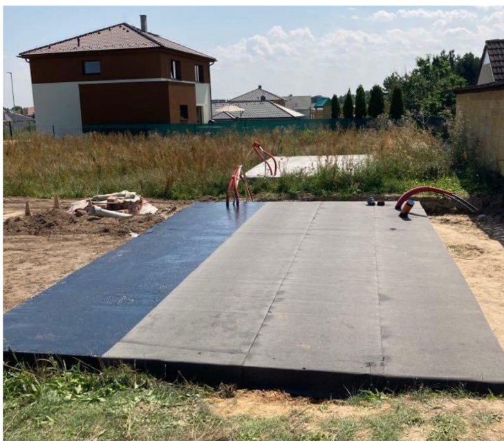
Obrázek 9 – Pokládka asfaltových hydroizolačních pásů
