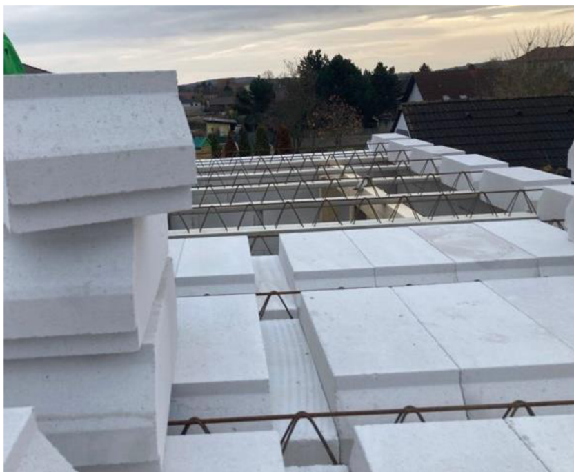
Obrázek 10 – Pokládka stropních dílců
