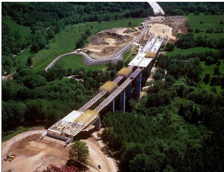
Obrázek 14: Stavba dálnice D8 přes CHKO České středohoří
