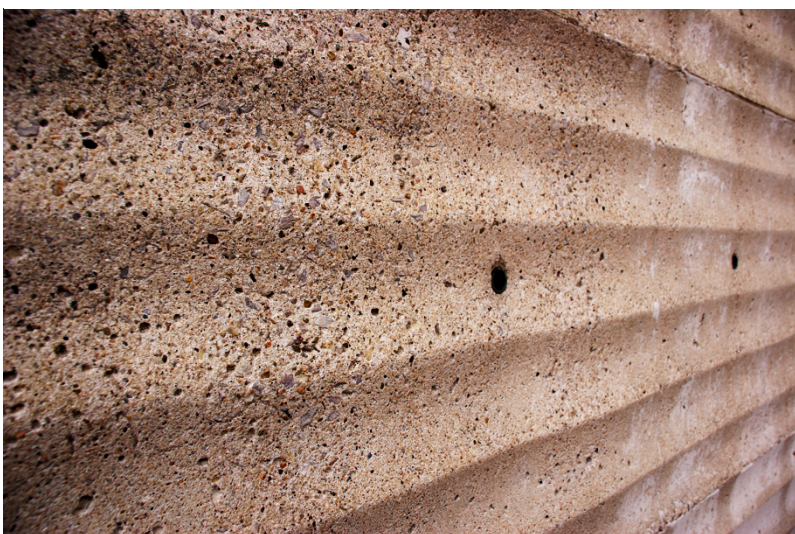
Obr. XVI. Detail struktury pohledového betonu, foto: Kristýna Radostová
