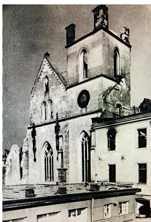
Obr. XX. Detail západního průčelí po náletu v roce 1945
