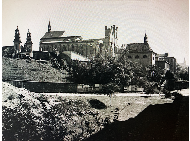
Obr. XXIII. Emauzy po dokončení I. etapy obnovy
