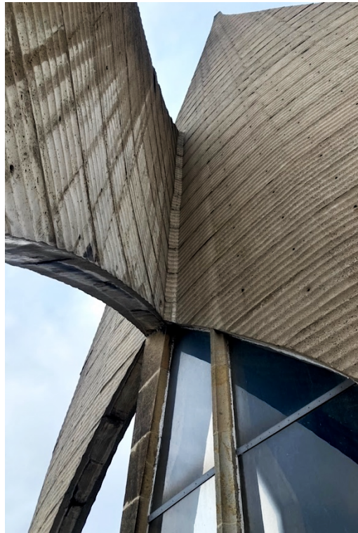
Obr. XII. Křížení opěrného systému věží, foto: Kristýna Radostová
