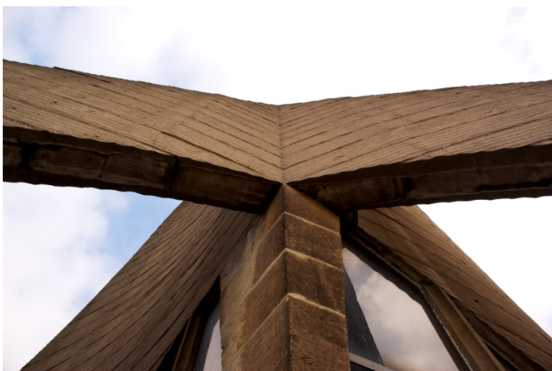
Obr. VI. Detail křížení věží s opěrným systémem, foto: Kristýna Radostová
