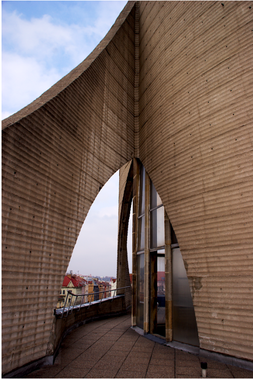
Obr. XI. Jižní část terasy pod věžemi kostela, foto: Kristýna Radostová
