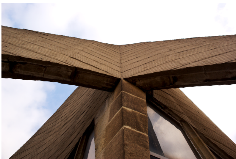
Obr. VI. Detail křížení věži s opěrným systémem, foto: Kristýna Radostová
