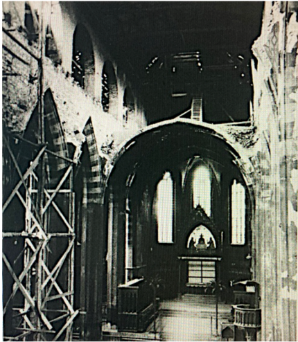
Obr. XXII. I. etapa obnovy vnitřku kostela
