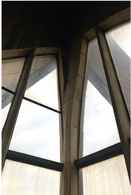
XIV. Detail prosklené stěny u terasy, foto: Kristýna Radostová
