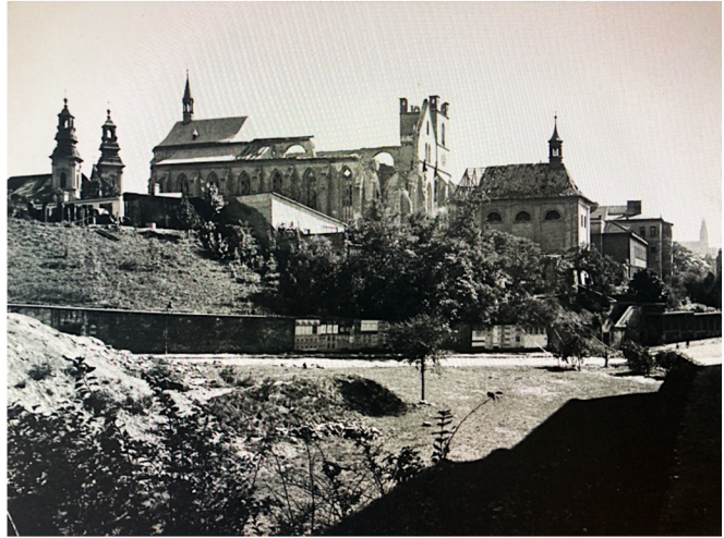
Obr. XXIII. Emauzi po dokončení 1. etapy obnovy
