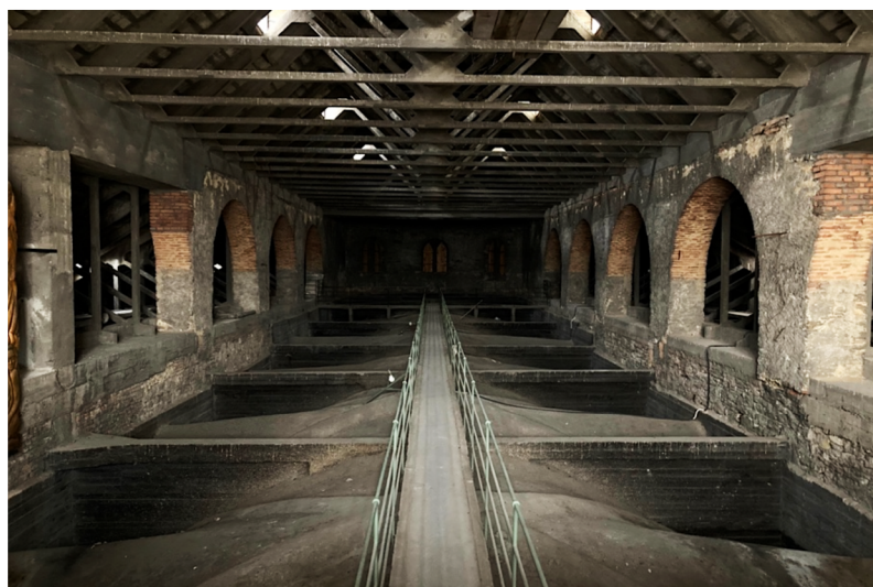
Obr. XIX. Interiér střechy kostela II, foto: Kristýna Radostová
