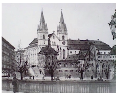
Obr. XVIII. Studie na dořešení prostoru pod Emauzským klášterem od Vratislava Hofmana a Viléma Dvořáka, 1912–13
