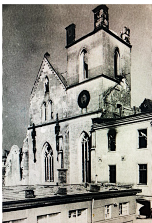
Obr. XX. Detail západního průčelí po náletu v roce 1945
