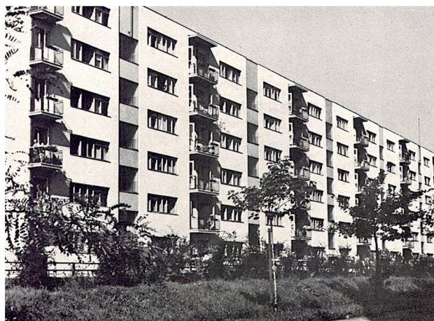
Obr. II. Nájemní domy v pražských Holešovicích, spolupráce s Kamilem Ossendorfem, stavba 1937–39
