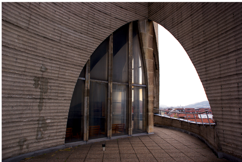
Obr. XV. Severní část terasy pod věžemi, foto: Kristýna Radostová
