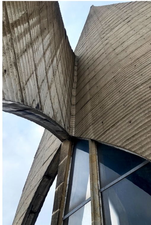
Obr. XII. Křížení opěrného systému věží, foto: Kristýna Radostová
