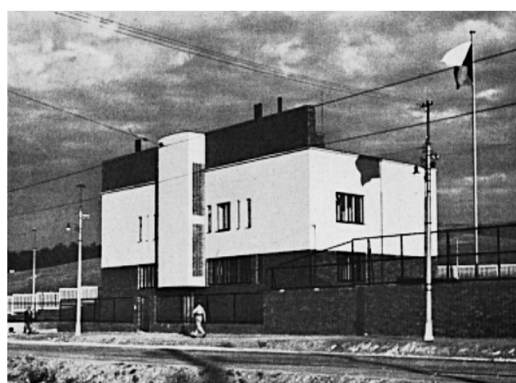
Obr. IV. Vozovna a administrační budova Elektrických drah hlavního města Prahy, stavba 1939
