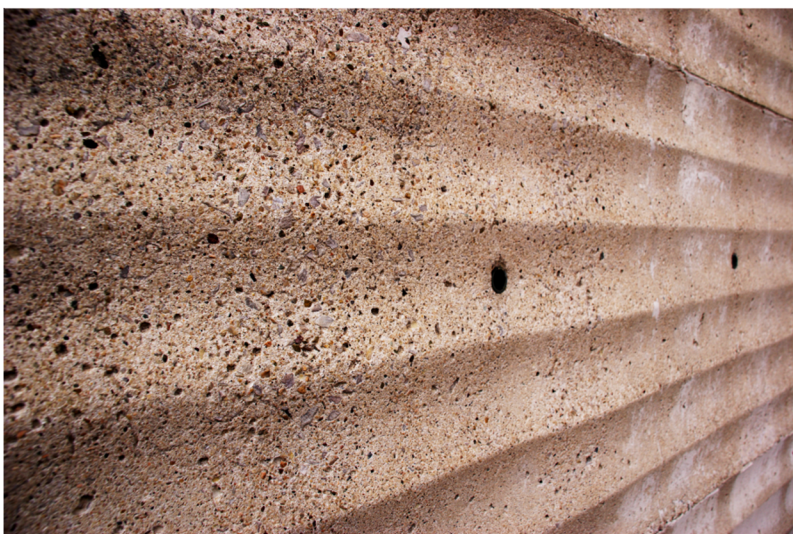
Obr. XVI. Detail struktury pohledového betonu, foto: Kristýna Radostová
