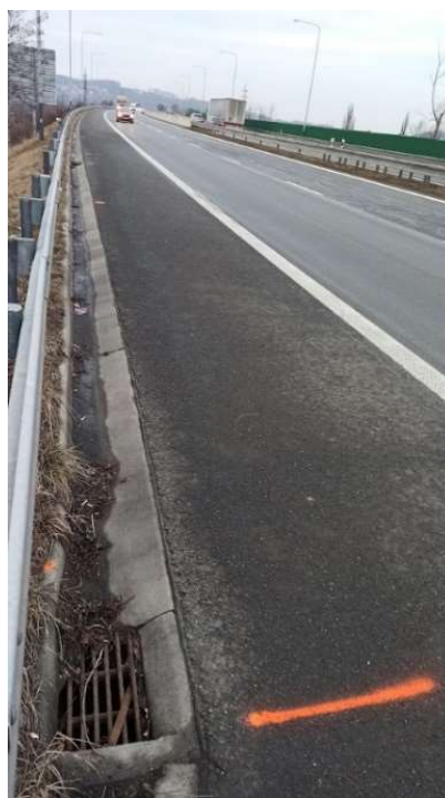
Obrázek 20 ukázka vyznačení skenovací oblasti na vozovce. [autor]
