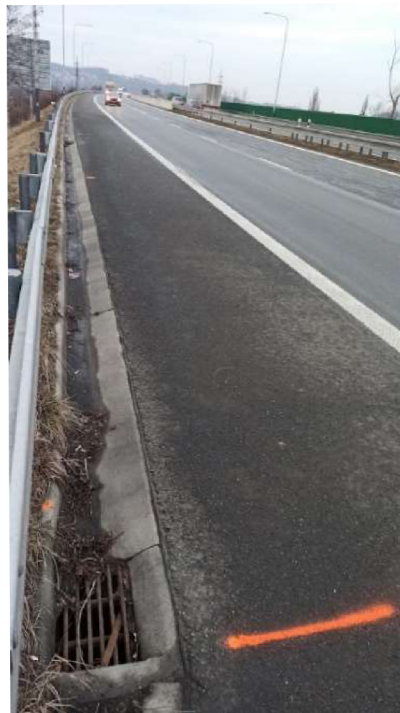
Obrázek 20 ukázka vyznačení skenovací oblasti na vozovce. [autor]
