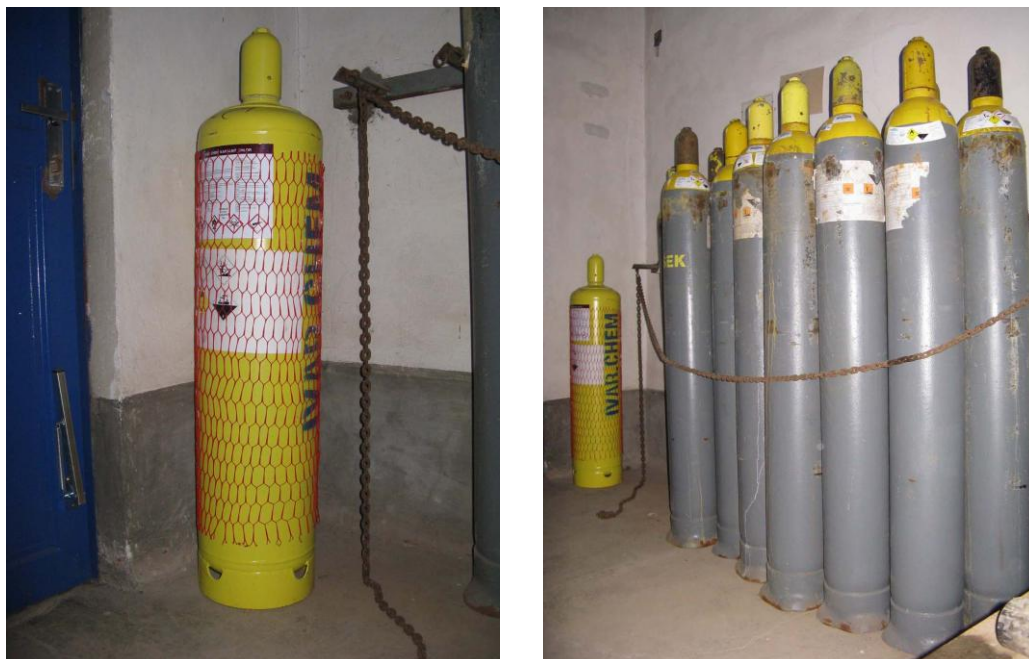
Obr. 12: Sklad chloru – nová (žlutá) tlaková lahev a stávající tlakové lahve
