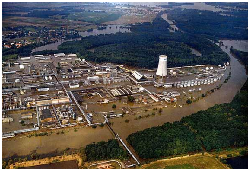
Obr. 7: Zaplavený areál Spolana Neratovice
