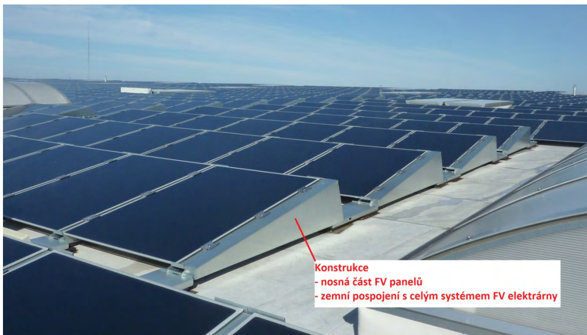
Obrázek 6.2 konstrukce FV panelů kapacitní spojení vůči zemi
