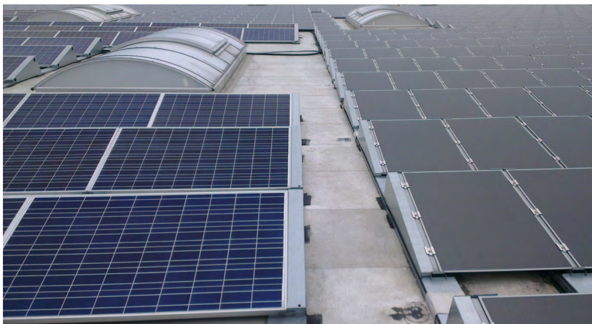
Obrázek 3.1 Polykrystalické panely (vlevo) a CIGS panely (vpravo)
