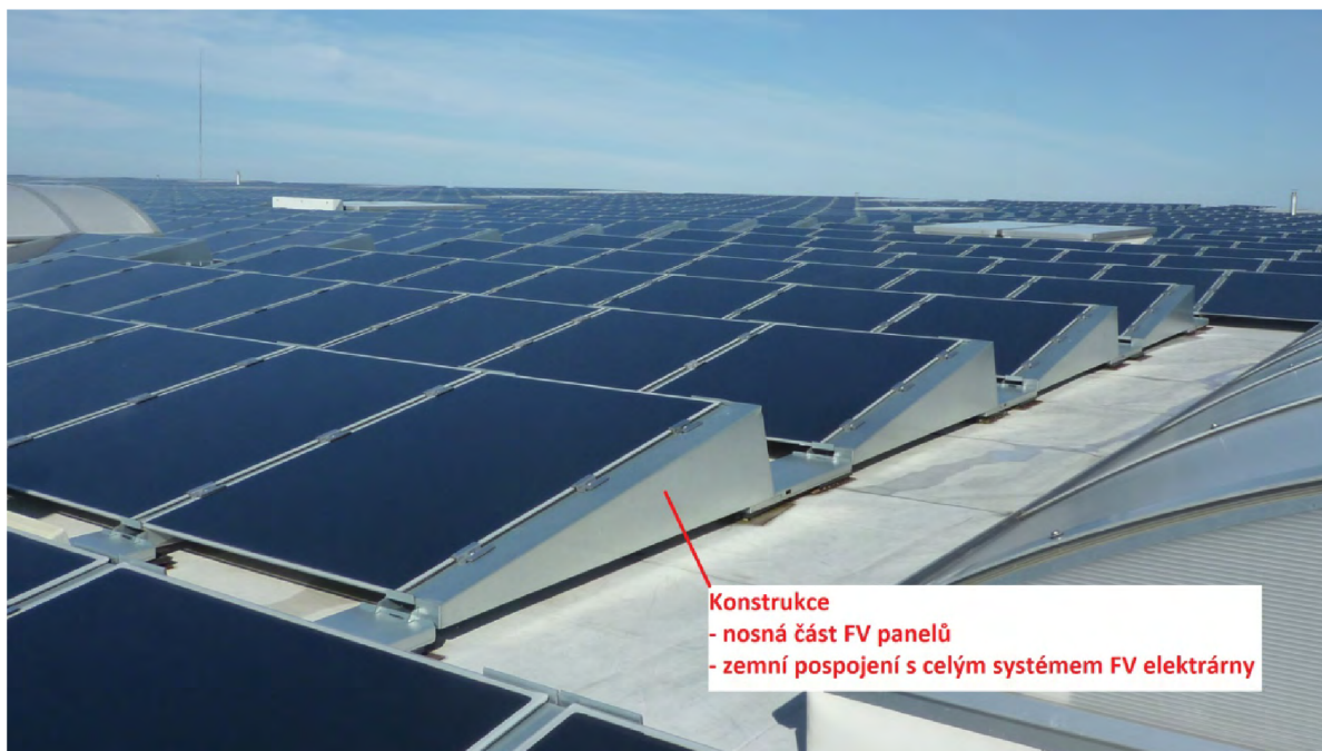
Obrázek 6.2 konstrukce FV panelů kapacitní spojení vůči zemi
