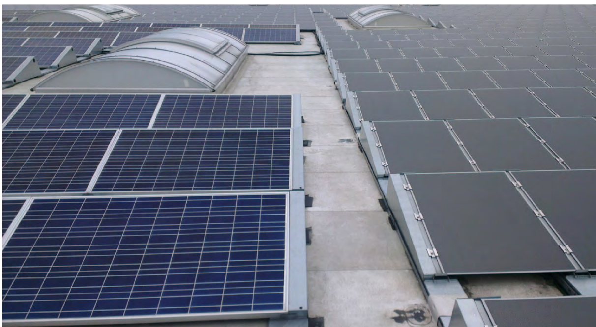
Obrázek 3.1 Polykrystalické panely (vlevo) a CIGS panely (vpravo)
