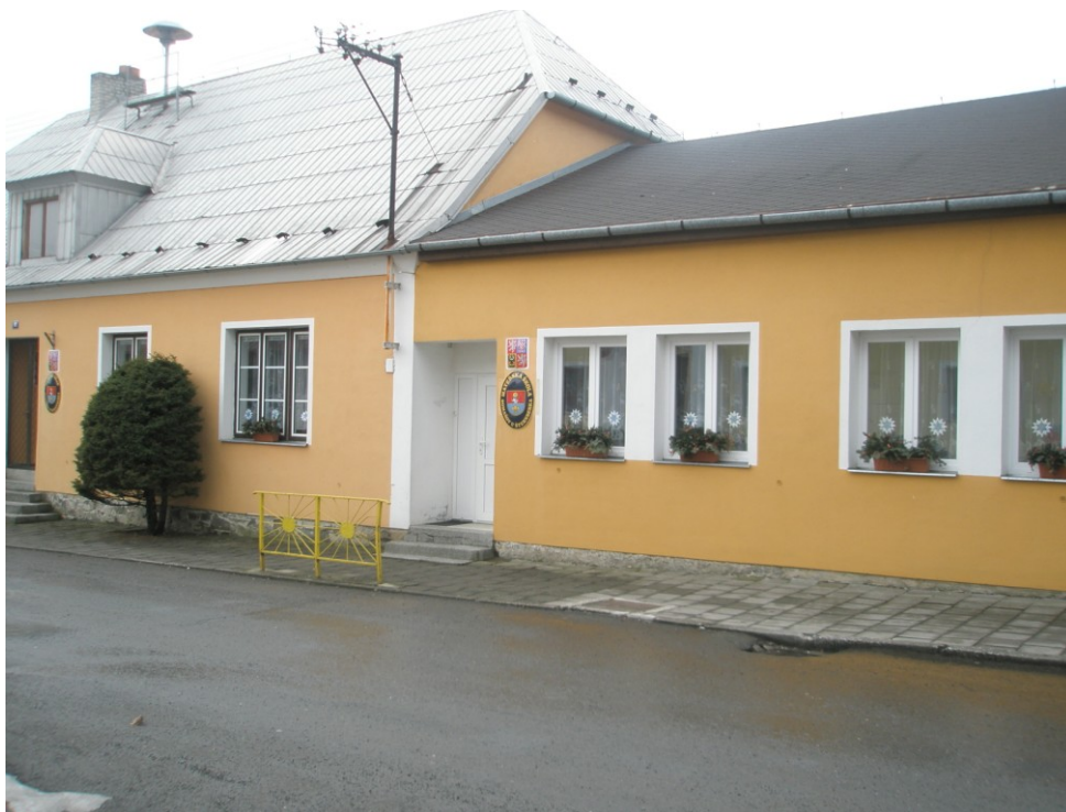
Obrázek č. 5.: Budova mateřské školy
