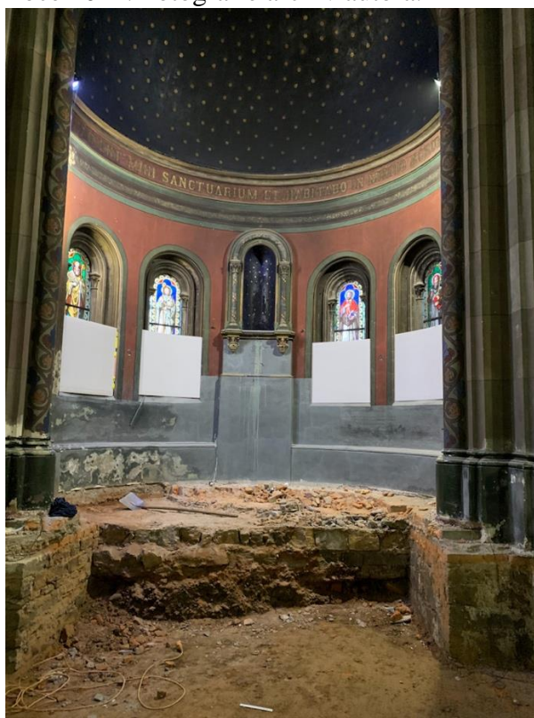
Příloha č. 119 – Fotografie výkopů v podlaze kaple při vytváření nového systému odvětrávání v roce 2022. Fotografie archiv autora.
