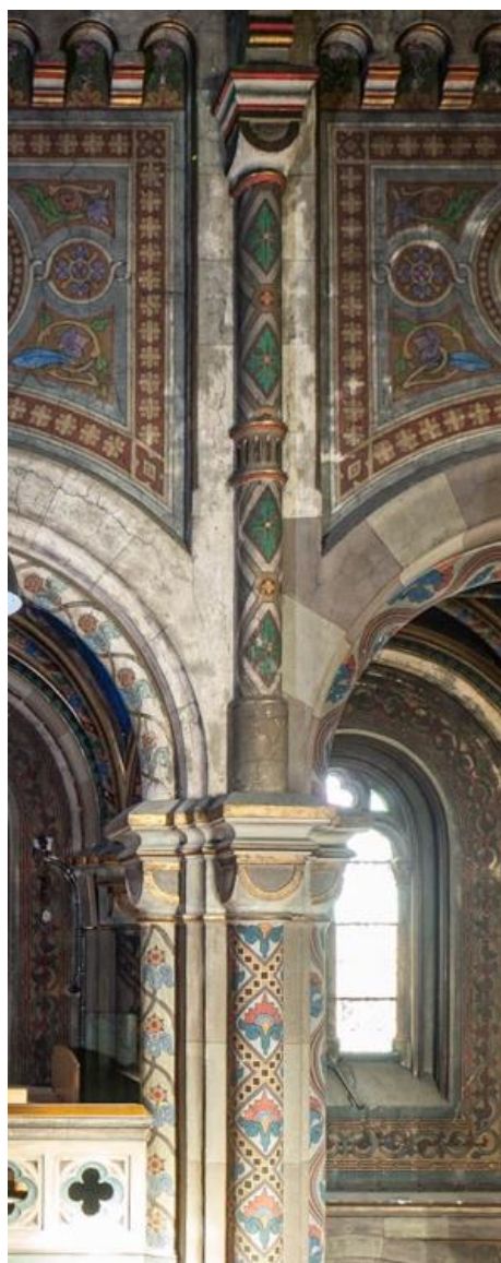
Příloha č. 53 – Detail vrchní podpory spojené se spodní podporou. Fotografie Ing. arch. Tomáš Šonovský.
