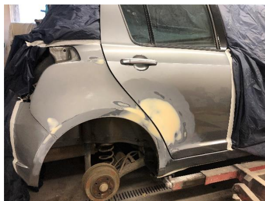
Obrázek 37 Tmelení poškozené karoserie Suzuki Swift - celek.
