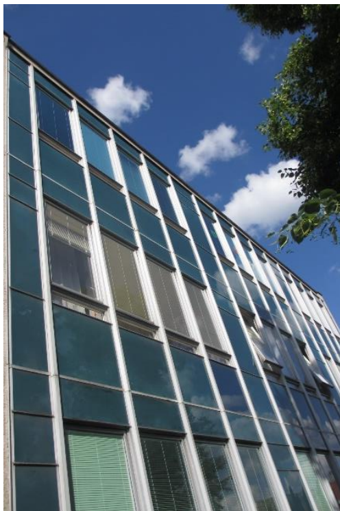
Obrázek 35 - Mateřská školka na ulici Na Stavidle, 1975.
