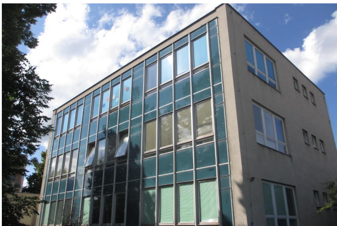
Obrázek 34 - Mateřská školka na ulici Na Stavidle, 1975.
