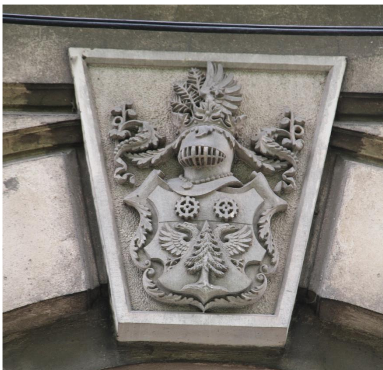
Obrázek 16 – Meziměstí, hlavní budova přádelny
