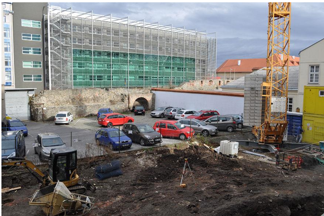
Obr. 54 Severní část staveniště v místech objektu Sokolská č. 5, pohled od jihozápadu. V pozadí dochované pozůstatky renesančního opevnění.
