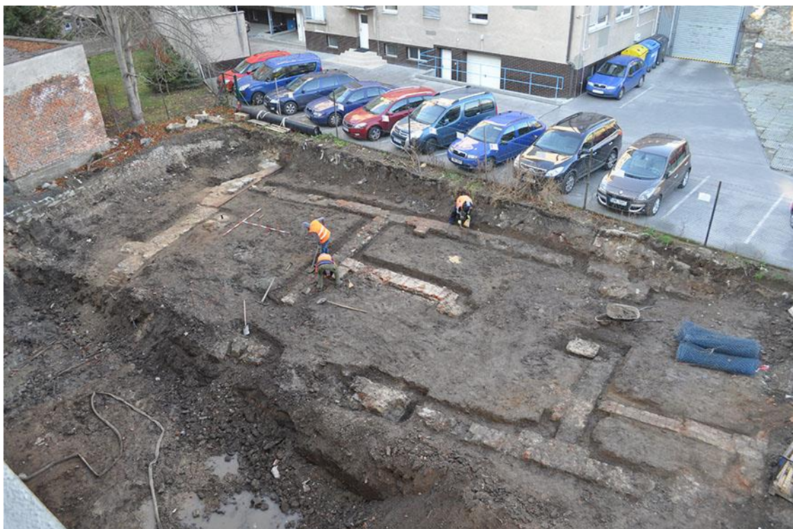
Obr. 56 Relikty zděné stavby v areálu někdejšího vojenského stavebního dvora v severní části zkoumané plochy staveniště domu Sokolská č. 5.
