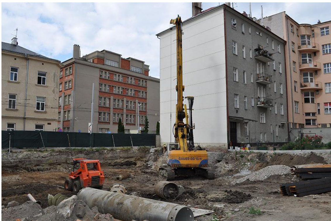
Obr. 50 Staveniště domu Sokolská č. 5, pohled od severovýchodu.
