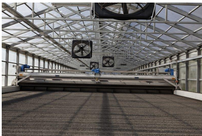
Obrázek 4.9: Příklad solární sušárny, zdroj: [29]
