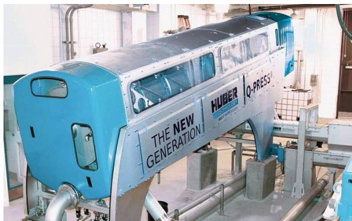
Obrázek 6.8: Zařízení pro odvodňování kalů HUBER Q-PRESS, zdroj: [51]
