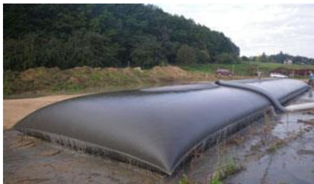
Obrázek 3.8: Příklad použití odvodňovacího vaku, zdroj: [22]
