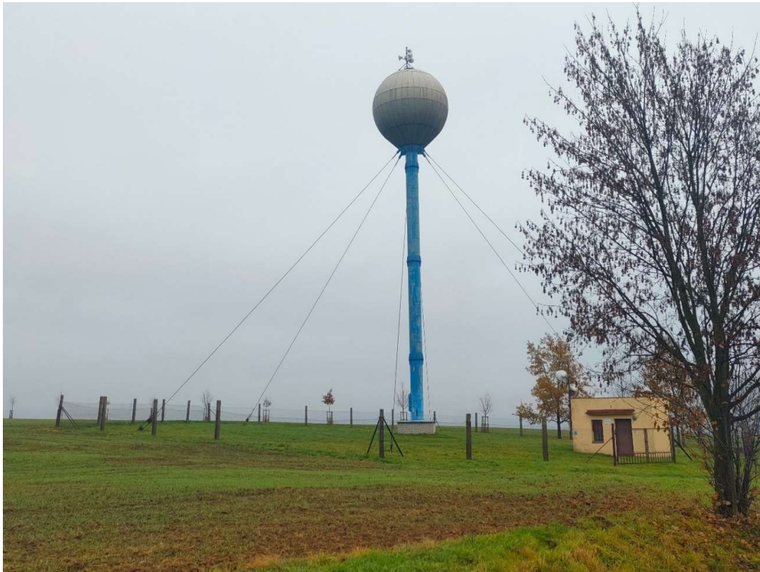
Obrázek 15. Pohled na věžový vodojem
