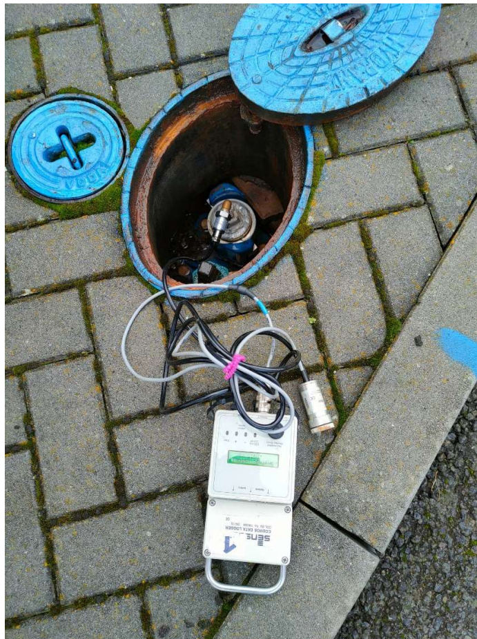
Obrázek 21. Osazení měřicího zařízení do hydrantu
