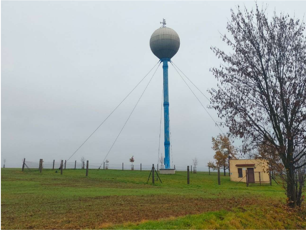
Obrázek 15. Pohled na věžový vodojem
