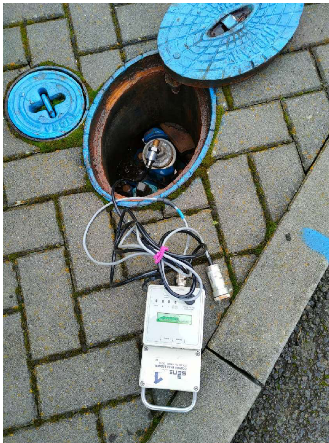
Obrázek 21. Osazení měřicího zařízení do hydrantu
