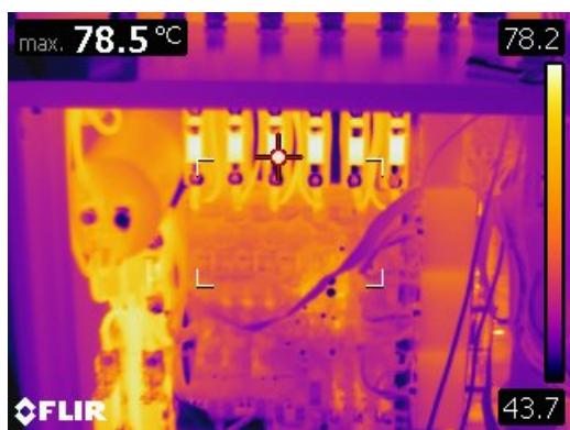
Obrázok 50: Termo kamera a.) vstupné poistky b.)Tyristory
