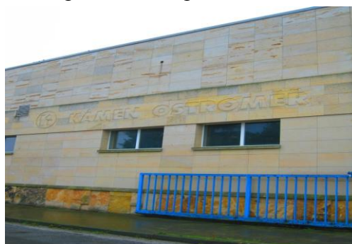
Obr. 31 Budova Kámen Ostroměř obložená hořickým pískovcem
