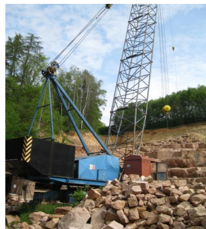
Obr. 9 Jeřáb na přepravu kamene, kamenolom Javorka
