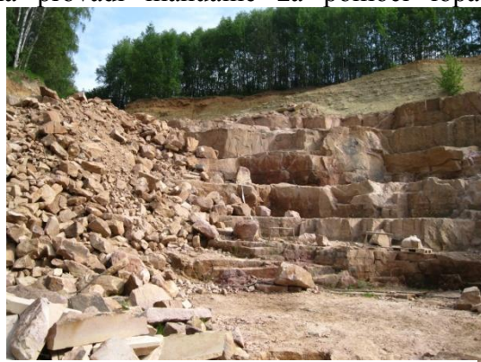
Obr. 5 Kamenolom Javorka – stěnový lom s mohutnou skrývkou
