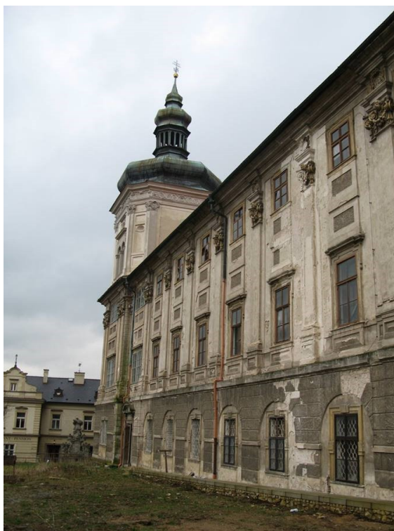
Obr. 16: Jezuitská kolej před rekonstrukcí
