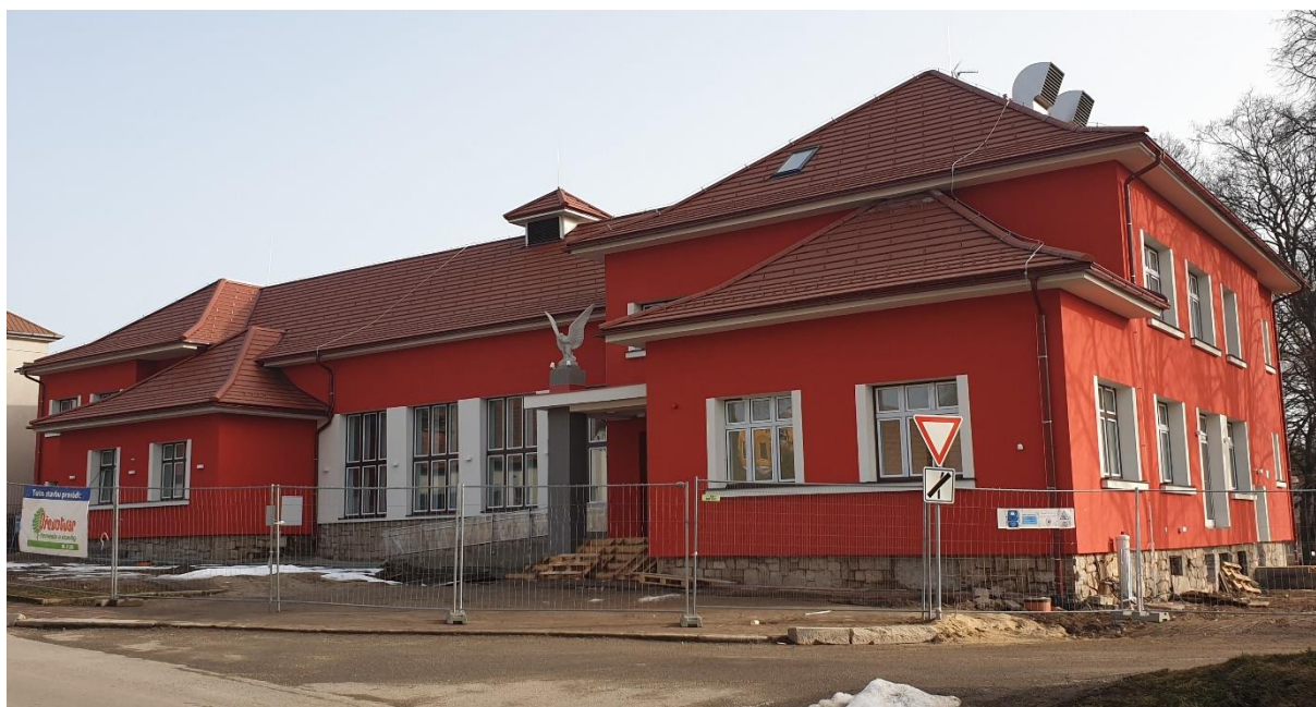
Obrázek 8: Černovická sokolovna během rekonstrukce
