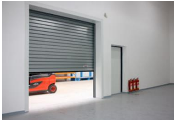
Obrázek 11: Požární vrata rolovací (5)
