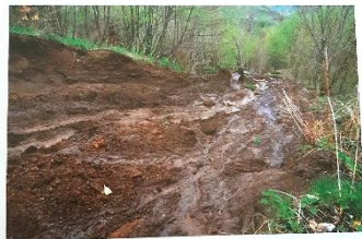
3.29 Jilovité půdy dokážou zadržovat velké množství vody. Po dlouhodobých deštích může třeba nastát voda v jilech způsobit pohyb celých svahů, čímž vznikne půdní sesuv . → 3U
