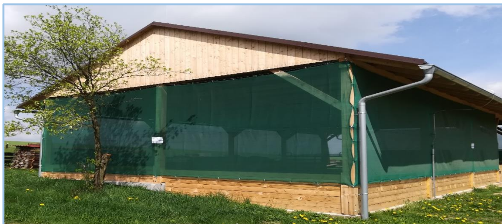
Obrázek 8 Novostavba přístřešku – zemědělská stavba Jiříkov
