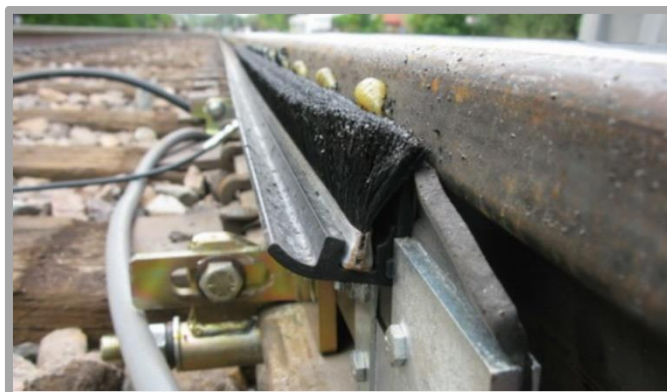
Obr. 3-10 Aplikační lišta Wiper bar připevněná na bok kolejnice [24]
