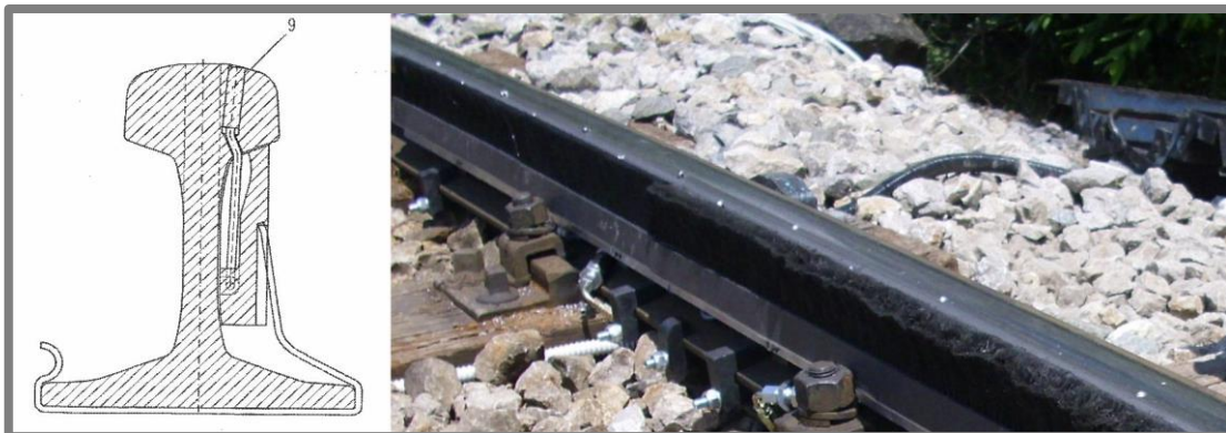
Obr. 3-24 ELPA CL-E1 top ws, vlevo senzor detekce náprav vpravo vrtaná kolejnice [40] [42]
