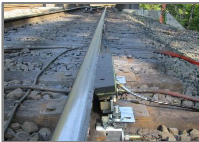
Obr. 3-12 Aplikační lišta Contact Applicator od firmy Lincoln [26]
