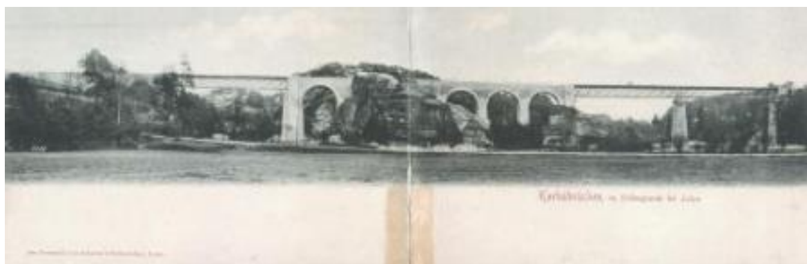
Obr. 14 – Pohled na údolí po výstavbě mostu
