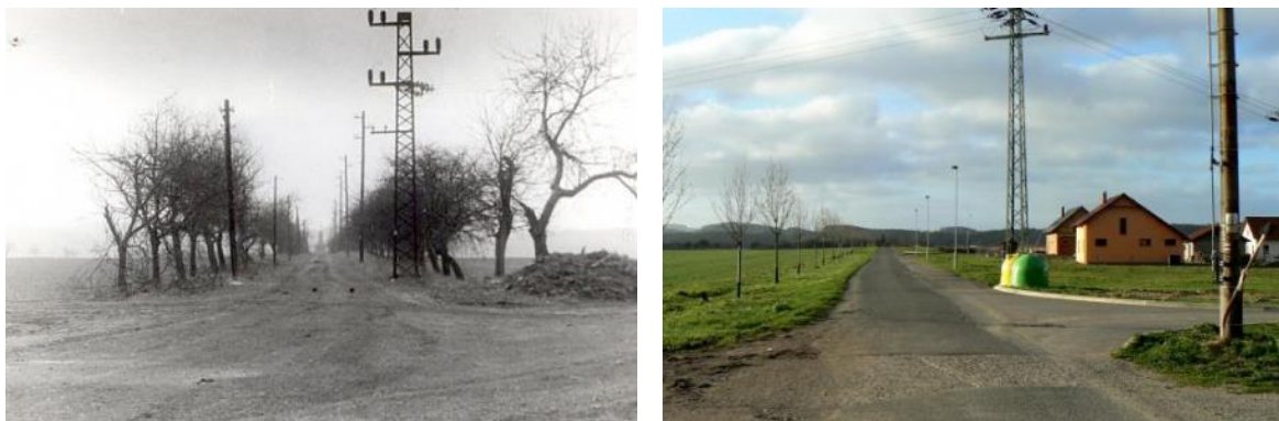
Obr. 17,18 – Výstavba rodinných domů u školy
