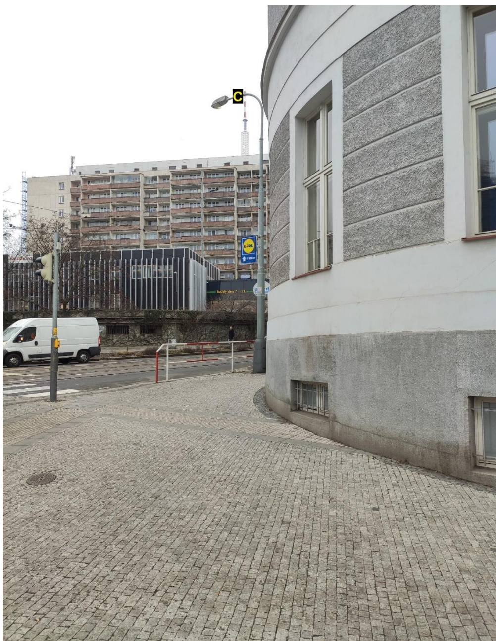
Obrázek 10 Pohled na objekt "C"
