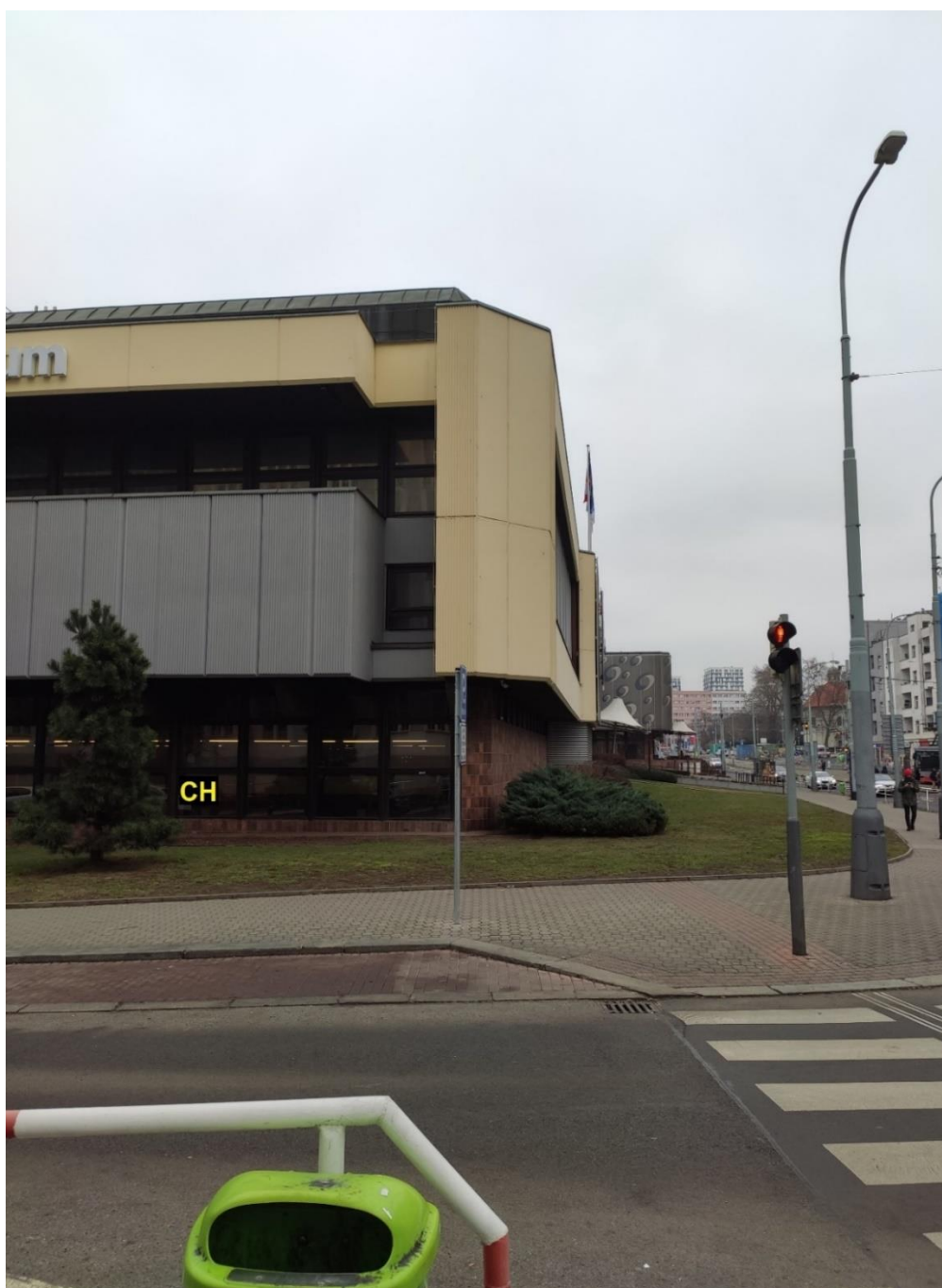
Obrázek 15 Pohled na objekt "CH"
