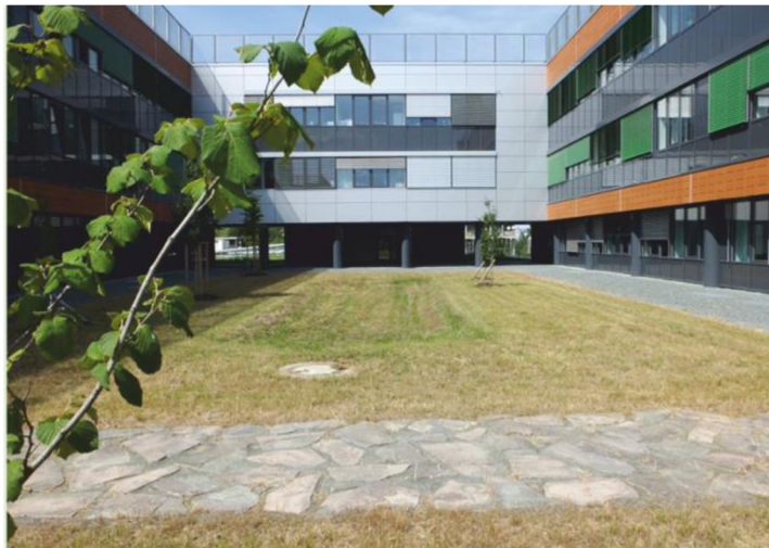
Obrázek 2b: Realizace vsakovacího průlehu v areálu Univerzitního kampusu Bohunice
