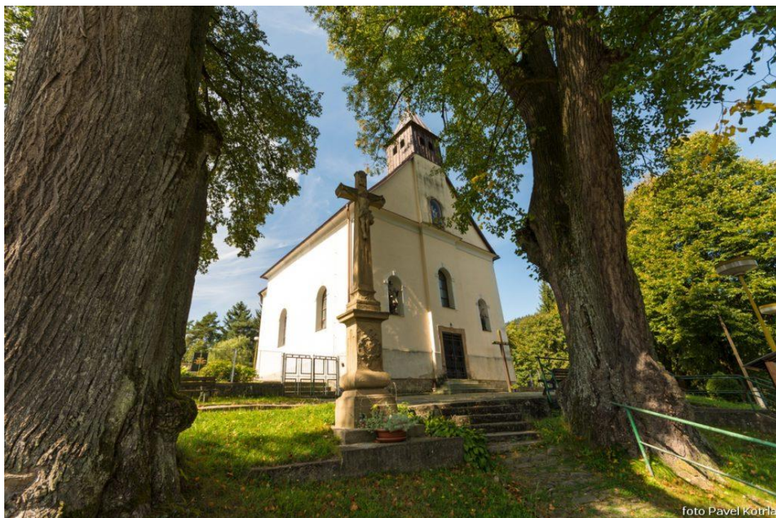
Obr. 4 Kostel Proměnění Páně (Pavel Kotrla ©2018)
