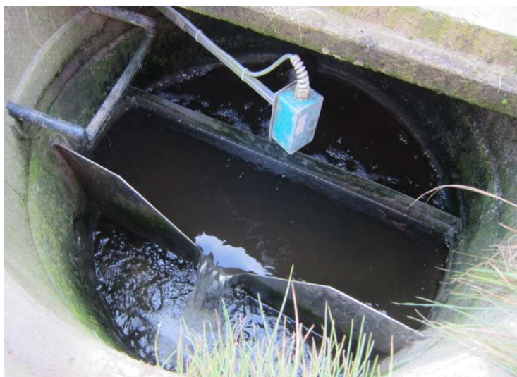
Obrázek 24: Příklad měření úrovně hladiny v kanalizační šachtě
