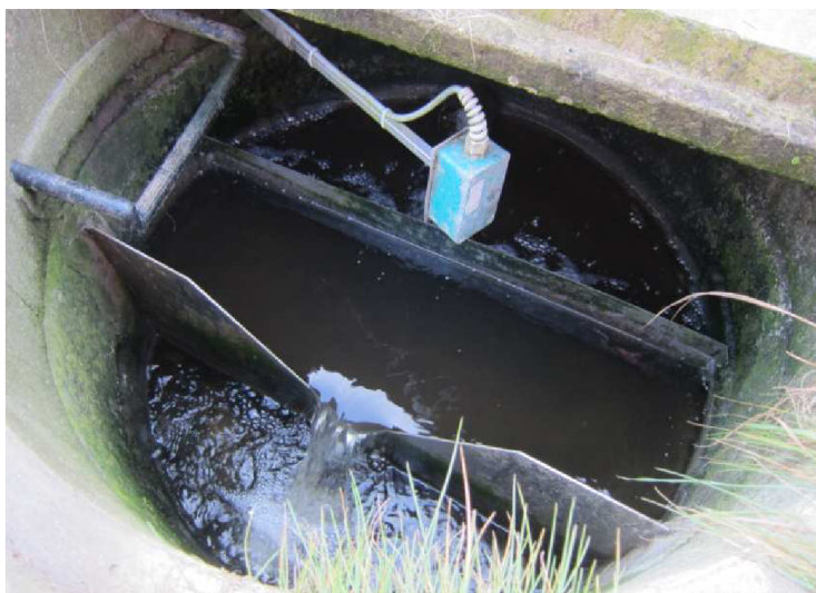
Obrázek 24: Příklad měření úrovně hladiny v kanalizační šachtě
