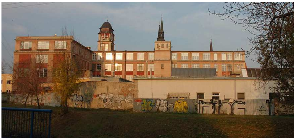
Obr.X: Fotodokumentace současného stavu areálu. Zdroj: archiv autora
