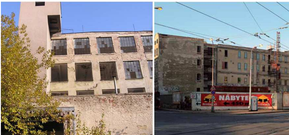
Obr.X : Původní stav hlavních budov areálu Moravanu. Zdroj : archiv autora
