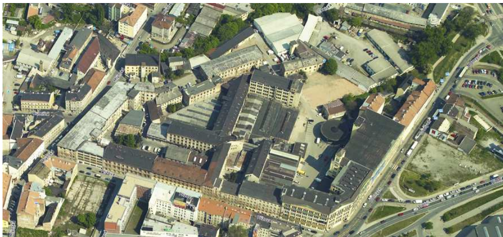
Obr.X : Letecký pohled ze severozápadu na areál textilního závodu Vlněna. Zdroj : Mapy.cz.
