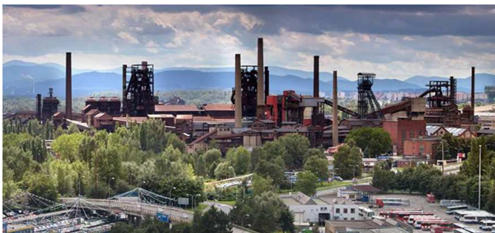
Obr.X : Dolní oblast Vítkovice v Ostravě. Zdroj : archiv Svět techniky.
