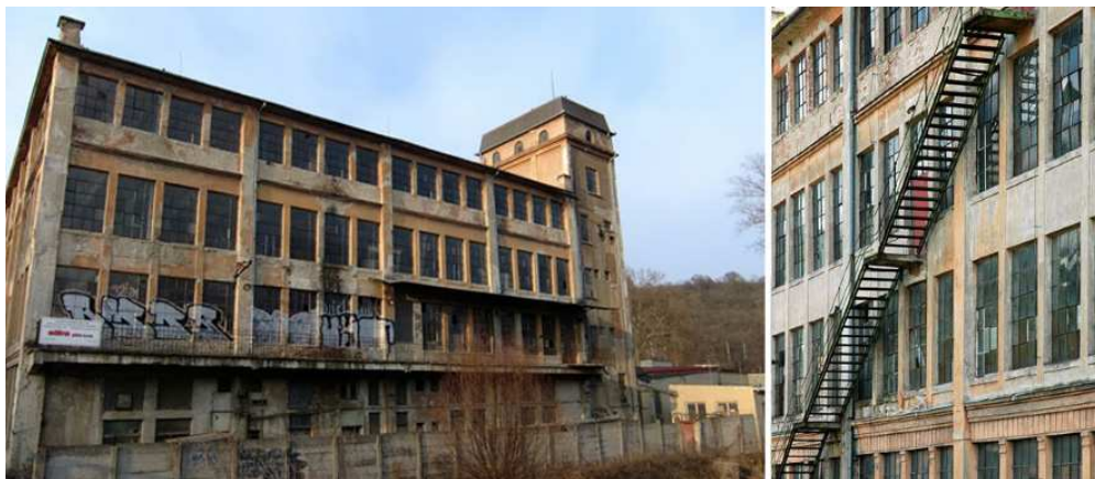
Obr.X: Fotodokumentace současného stavu dominanty areálu objektu bývalé přádelny - nevyužívaná. Zdroj: archiv autora
