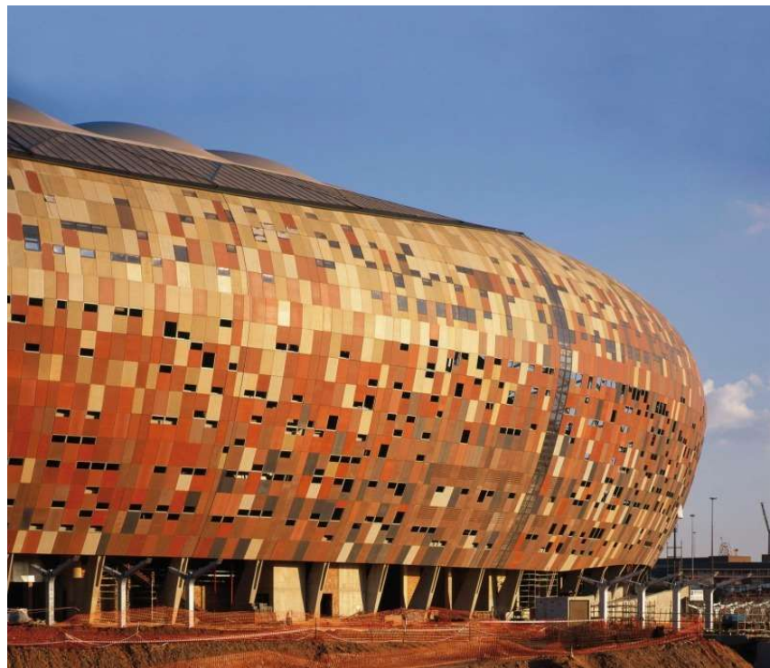
Obr. 6 Pohled na barevnou fasádu FNB stadionu
