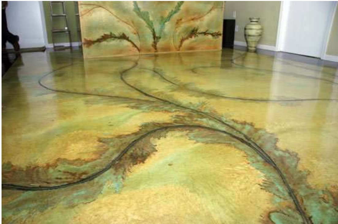
Obr. 9 Povrch betonu leptaný kyselinou
