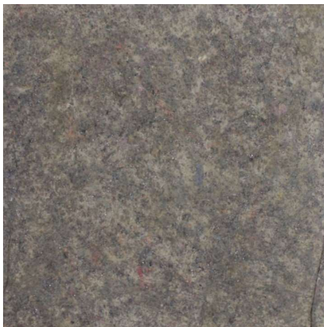
Obr. 33 Betonový povrch s rounovou vložkou pro Recepturu I
