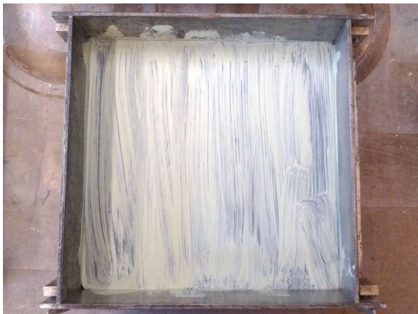
Obr. 43 Bednění opatřeno deaktivujícím nátěrem
