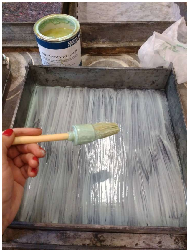
Obr. 42 Nanášení deaktivátoru betonového povrchu na bednění
