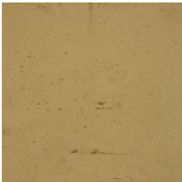
Obr.30 Betonový povrch s netkanou textilní vložkou pro Recepturu II
