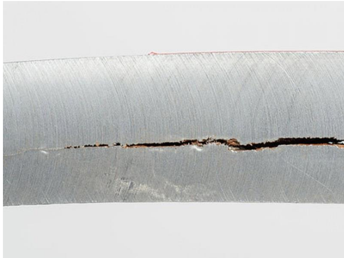
Obr. 17 Narušení materiálu vlivem korozního praskání [39]
