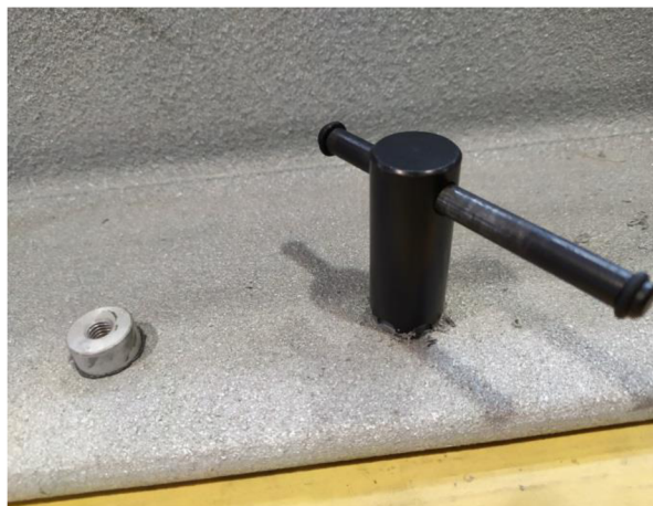
Obr. 55 Proříznutí okolí terče ruční frézou
