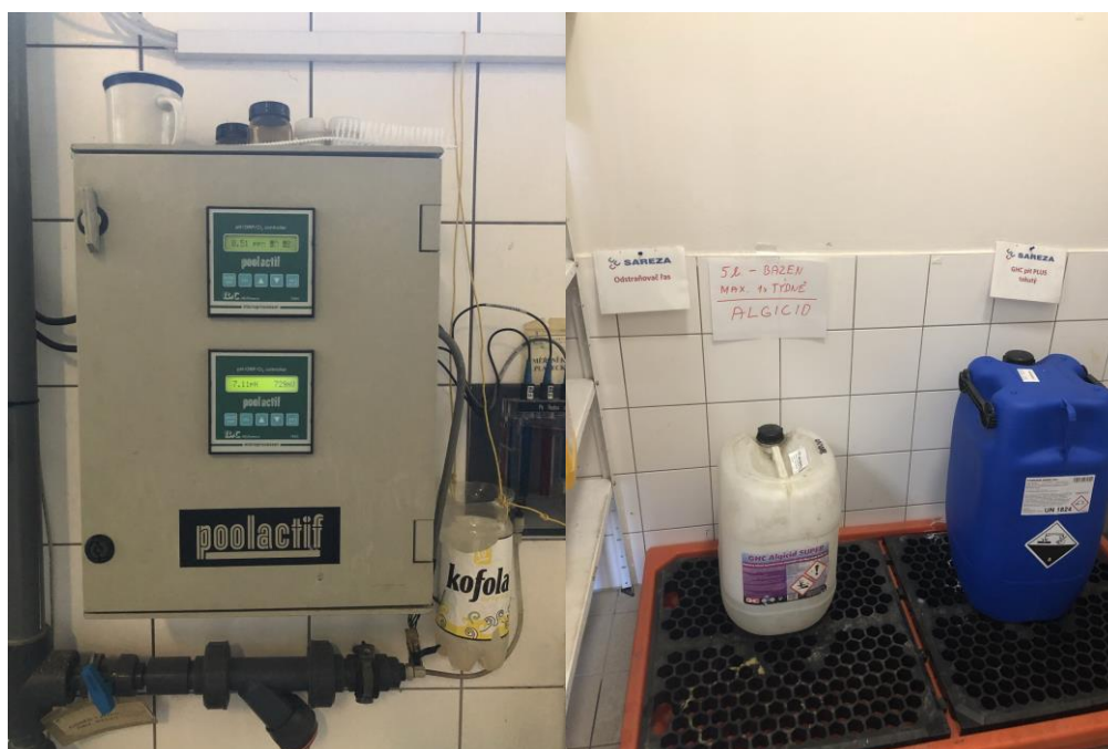
Obr. 4.15 Řídicí jednotka Poolactif (vlevo) a barel algicidu a korektoru pH (vpravo)
