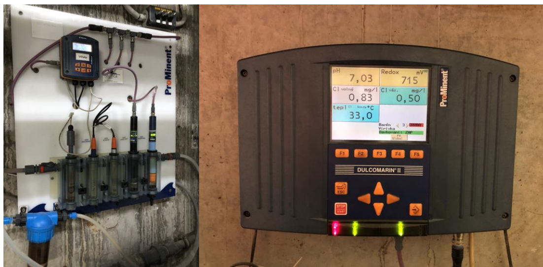
Obr. 2.15 MaR (vlevo) a regulační jednotka ProMinent (vpravo) [foto autor]
