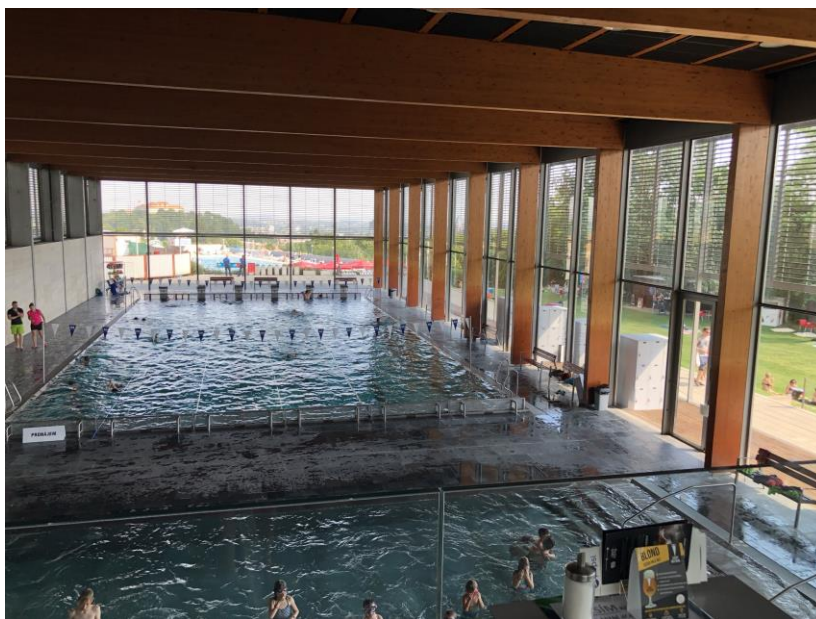
Obr. 4.28. Vnitřní prostor areálu Kraví hora – plavecká hala
