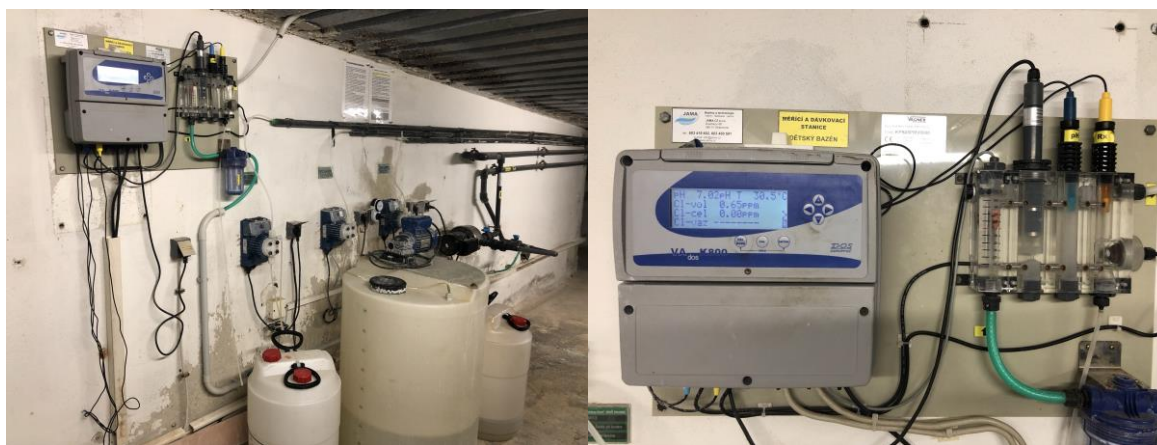
Obr. 4.19 Řídicí jednotka s dávkovacími čerpadly
