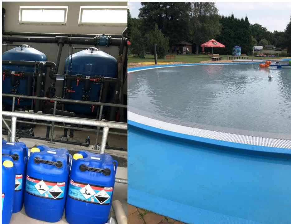
Obr. 4.12 Pohled do malé úpravný s barely chlornanu sodného (vlevo) a detail dětského bazénu (vpravo)
