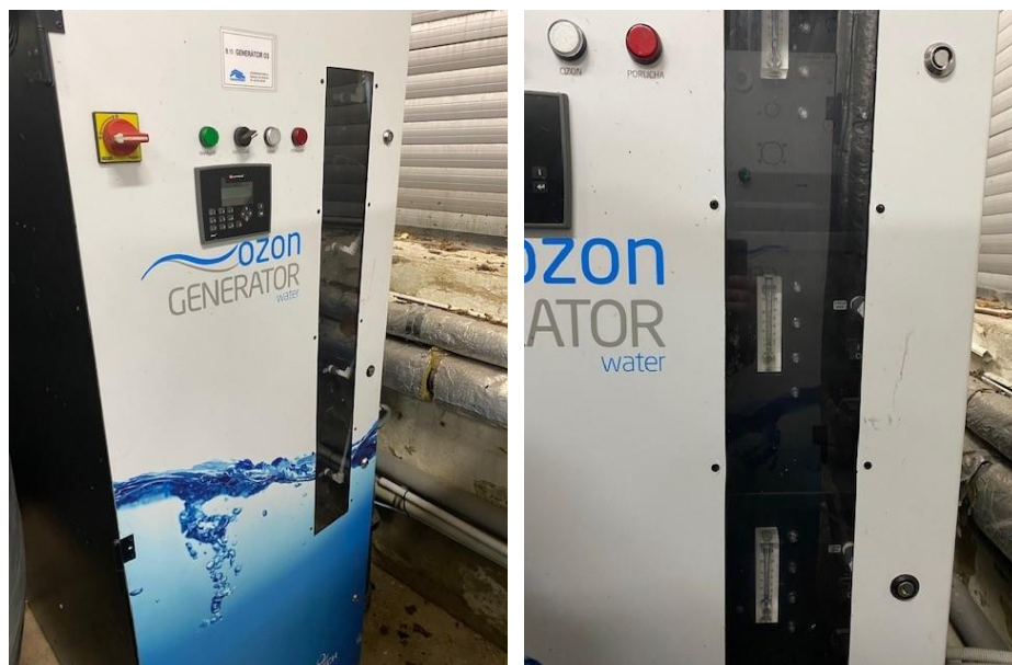
Obr. 4.5 Generátor ozonu firmy Ozontech v TM koupaliště Riviéra
