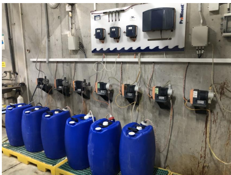
Obr. 3.4 Dávkování chlornanu sodného [foto autor]
