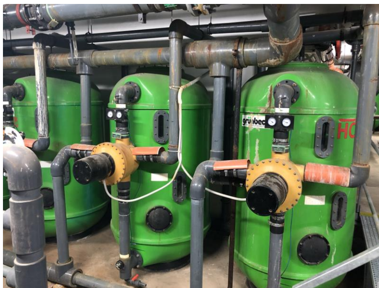
Obr. 4.21 Pískové tlakové filtry GRUNBECK
