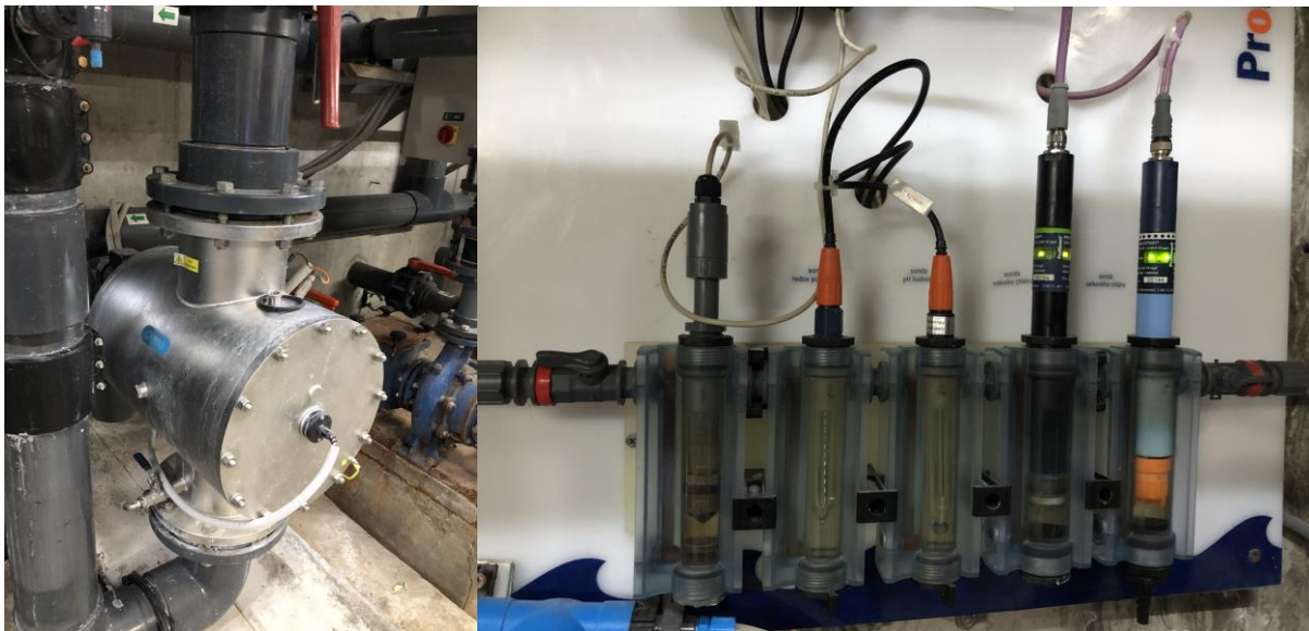
Obr. 4.30 Vlevo jednotka UV a vpravo měřicí sondy pro vířivku
