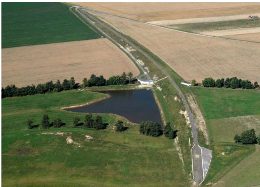
Obr. 34. Ilustrační obrázek suché retenční nádrže s trvalou vodní plochou v zátopě [43]
