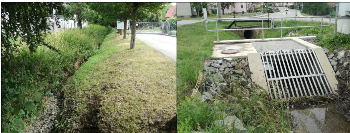
Obr. 13. Koryto Pozořického potoka v intravilánu (vlevo), odlehčovací objekt na Pozořickém potoce (vpravo)
