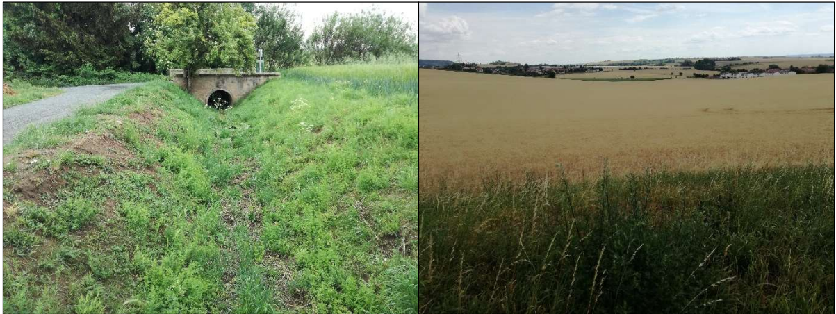
Obr. 20. Pohled na ZP3 na vtoku do propustku DN 800 (vlevo), sběrné povodí P5 k ZP5 (vpravo)
