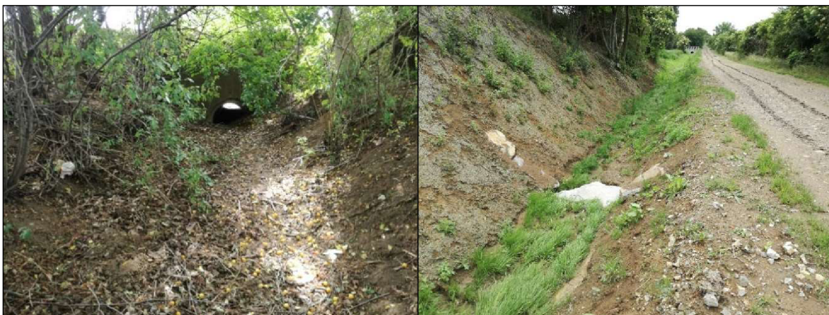
Obr. 11. Koryto Tvaroženského potoka (vlevo), cestní příkop odvádějící vodu z odlehčení do vodní nádrže VN3 (vpravo)
