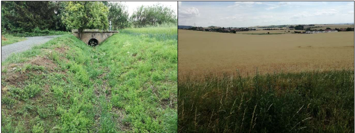
Obr. 20. Pohled na ZP3 na vtoku do propustku DN 800 (vlevo), sběrné povodí P5 k ZP5 (vpravo)
