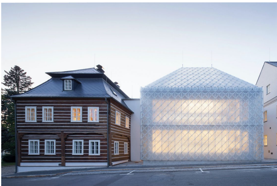
Obrázek 8: sídlo společnosti LASVIT s. r. o. Zdroj: (Archiweb, 2019)
